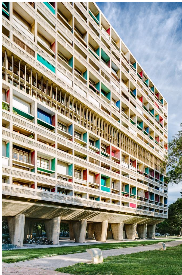
Fig.13. Unité d'habitation de Marsella de Le Corbusier , 1945. (Fuente: Internet)
