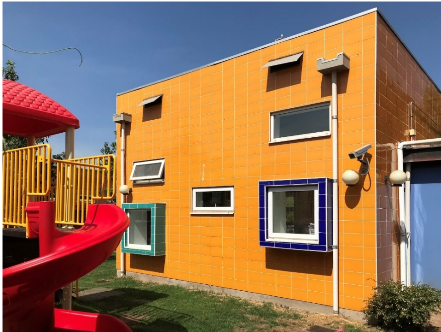
Fig. 3.11 Sala donde se realizan las visitas. Elaboración propia.
