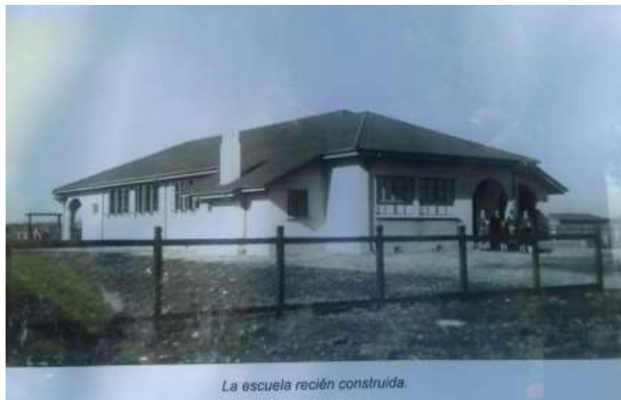
Figura 32 Fotografía de la escuela Dolores Cattín Faúndez recién construida Fuente: Museo Municipal Peñaflores.
