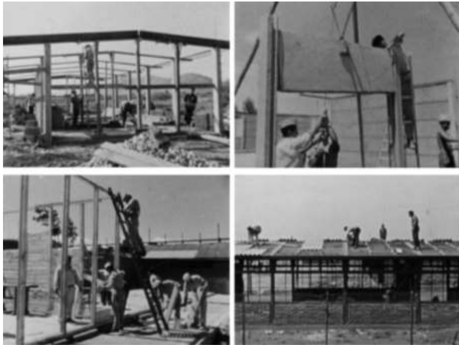
Figura 7: Fotogramas que muestran el montaje de prefabricación con la colaboración de albañiles y voluntarios. Fuente: (Eduardo & Montalva, 1976)
