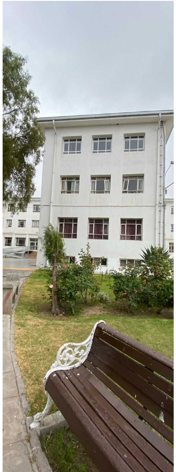
Figura 53: Bloque H desde patio interior. Elaboración propia.
