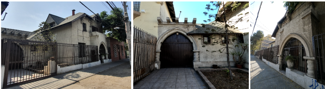
Figura N°19- Fachada y accesos de la vivienda en Calle San Eugenio 92. - Fuente: Elaboración propia.
