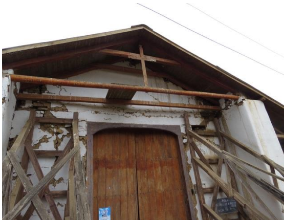
Ilustración 162: Detalle del estado de la estructura muraria, año 2019. Fuente: Ibidem.
