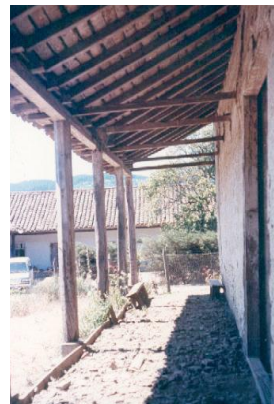
Ilustración 135: Detalle del corredor lateral de la capilla hacia el año 2004.
