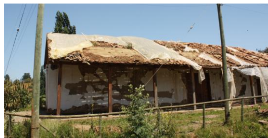
Ilustración 151: Vista de la fachada nor oriente, año 2010, posterior a terremoto 27 febrero. Fuente: Ibidem.
