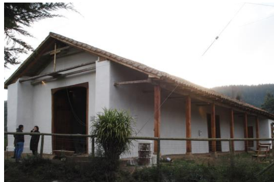
Ilustración 143: Vista de la fachada nor oriente hacia el año 2007. Fuente: Ibidem.
