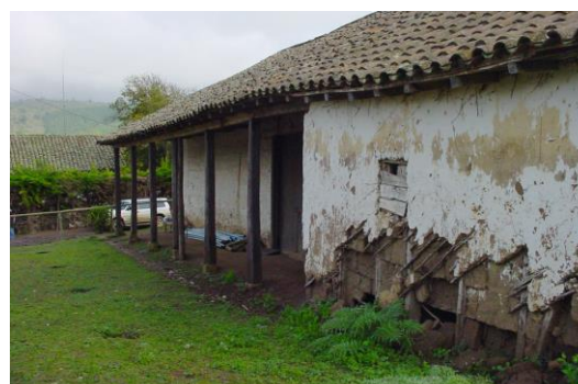
Ilustración 139: Vista de la fachada nor oriente hacia el año 2005.
