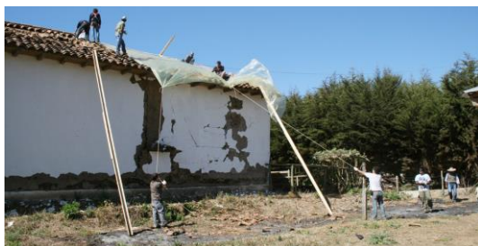
Ilustración 150: Vista de la fachada sur poniente, año 2010, posterior a terremoto 27 febrero. Fuente: Ibidem.
