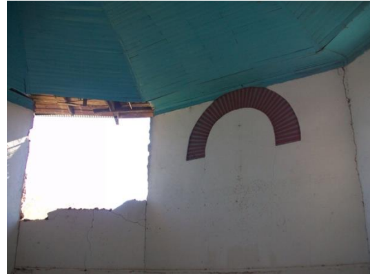
Ilustración 68: Detalle vaciamiento muro testero, agosto 2010. Fuente: Ibídem.
