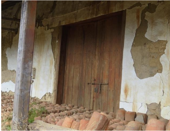
Ilustración 166: Detalle del estado del acceso lateral, año 2019. Fuente: Ibidem.
