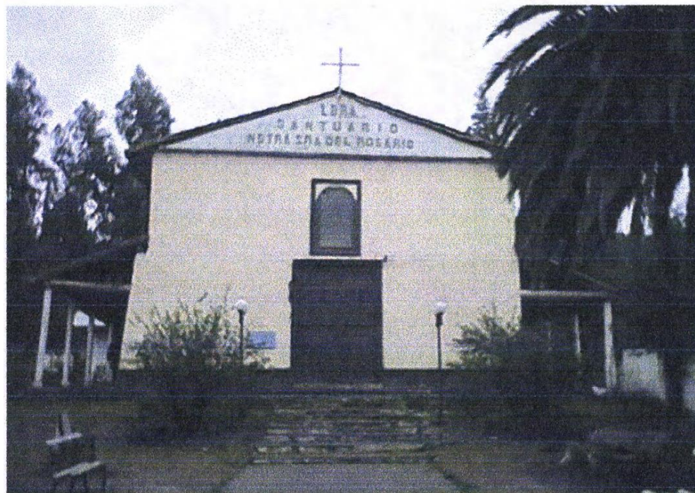
Ilustración 88: Vista fachada principal previo a intervención aprobada en el año 2005. Fuente: Expediente Técnico de Declaratoria, Coordinación Regional CMN.
