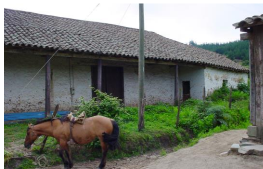
Ilustración 131: Vista de la fachada nor oriente hacia el año 2003. Fuente: Ibidem.
