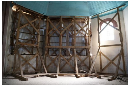
Ilustración 72: Detalle de obras de emergencia implementadas en el ábside, enero 2019. Fuente: Ibídem.
