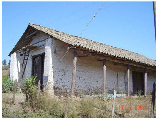
Ilustración 134: Vista lateral de la capilla hacia el año 2004.
