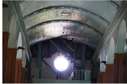
Ilustración 74: Detalle bóveda de cañón corrido, mayo 2018. Fuente: Ibídem.
