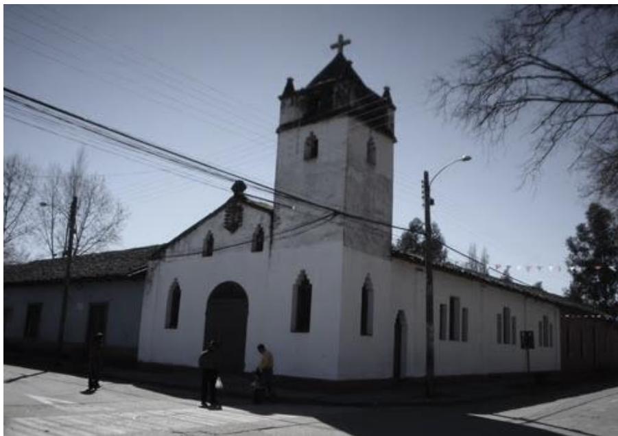
Ilustración 172: Vista lateral de la parroquia y casa parroquial, imagen anterior al terremoto de febrero de 2010.
