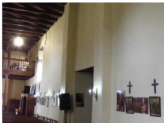
Ilustración 95: Interior del santuario, muro nor poniente, enero 2019. Fuente: Ibidem.
