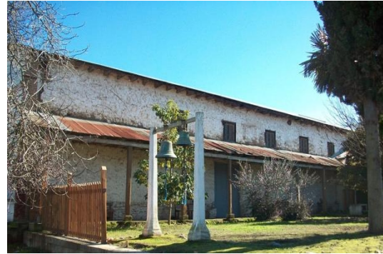
Ilustración 62: Detalle del campanario exento, octubre 2008. Fuente: Ibídem.
