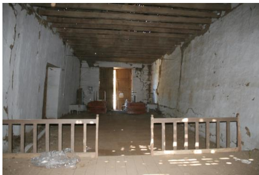
Ilustración 152: Vista del interior de la capilla hacia el acceso, año 2010, posterior a terremoto 27 febrero. Fuente: Ibidem.
