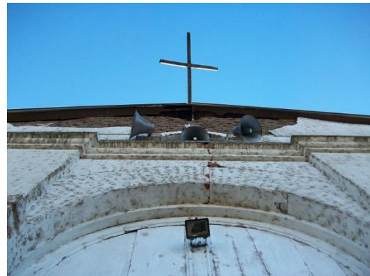
Ilustración 64: Detalle del frontón de la fachada sur del santuario, agosto 2010. Fuente: Ibídem.
