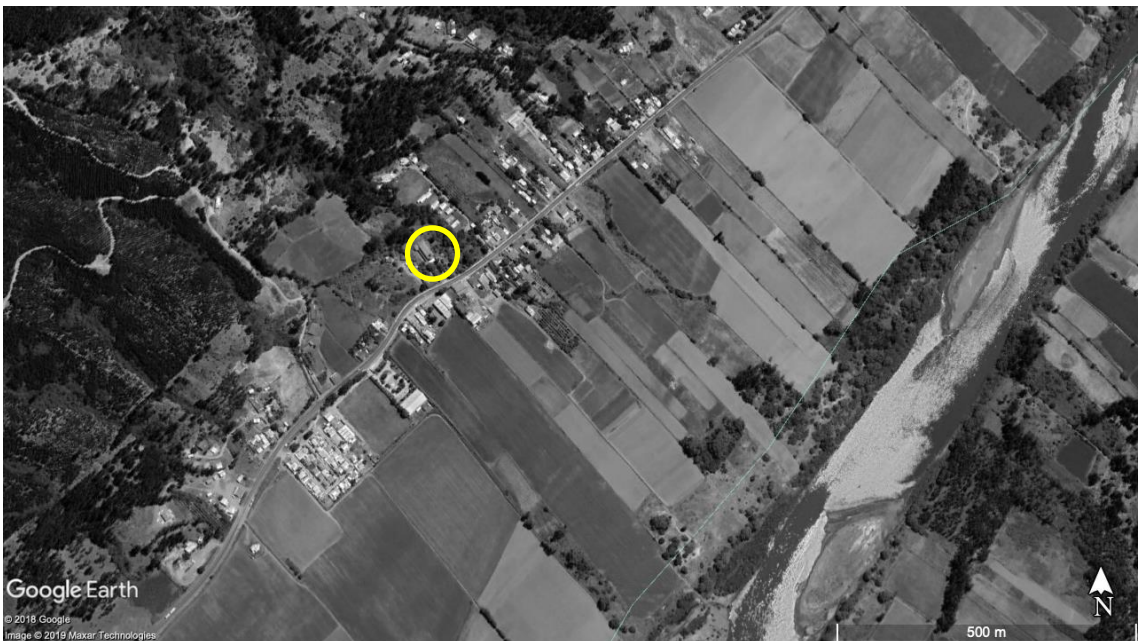
Ilustración 83: Vista general aérea del emplazamiento. Fuente: Google Earth Pro. Fecha imagen 2018.
