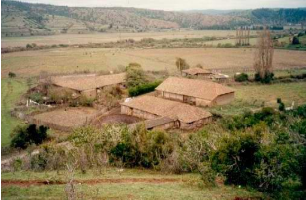
Ilustración 127: Vista general del entorno, imagen sin data. Fuente: Archivo digital Dirección Regional de Arquitectura, MOP región del Maule.
