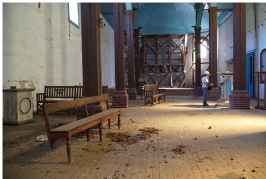
Ilustración 71: Vista del interior del templo hacia el ábside, enero 2019. Fuente: Ibídem.
