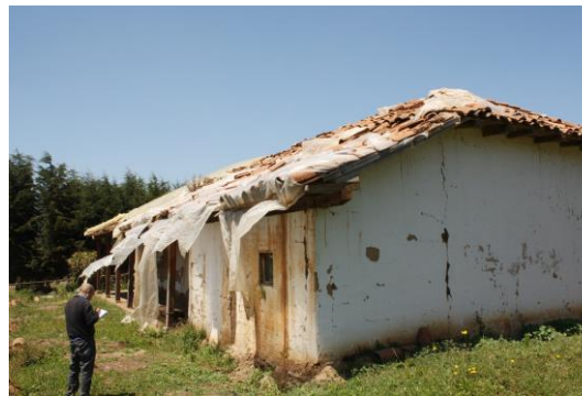
Ilustración 149: Vista de la fachada nor oriente, año 2010, posterior a terremoto 27 febrero. Fuente: Ibidem.
