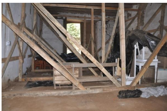
Ilustración 158: Interior nave, vista hacia acceso, año 2012. Fuente: Ibidem.
