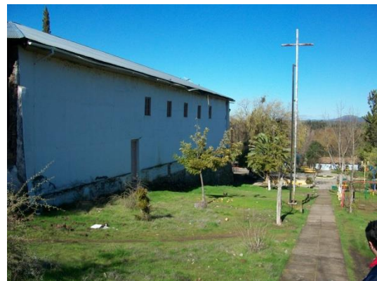
Ilustración 66: Vista de la fachada poniente del santuario, agosto 2010. Fuente: Ibídem.
