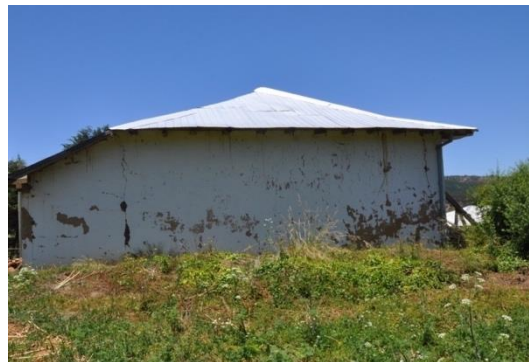
Ilustración 155: Vista de la fachada posterior, año 2012. Fuente: Ibidem.
