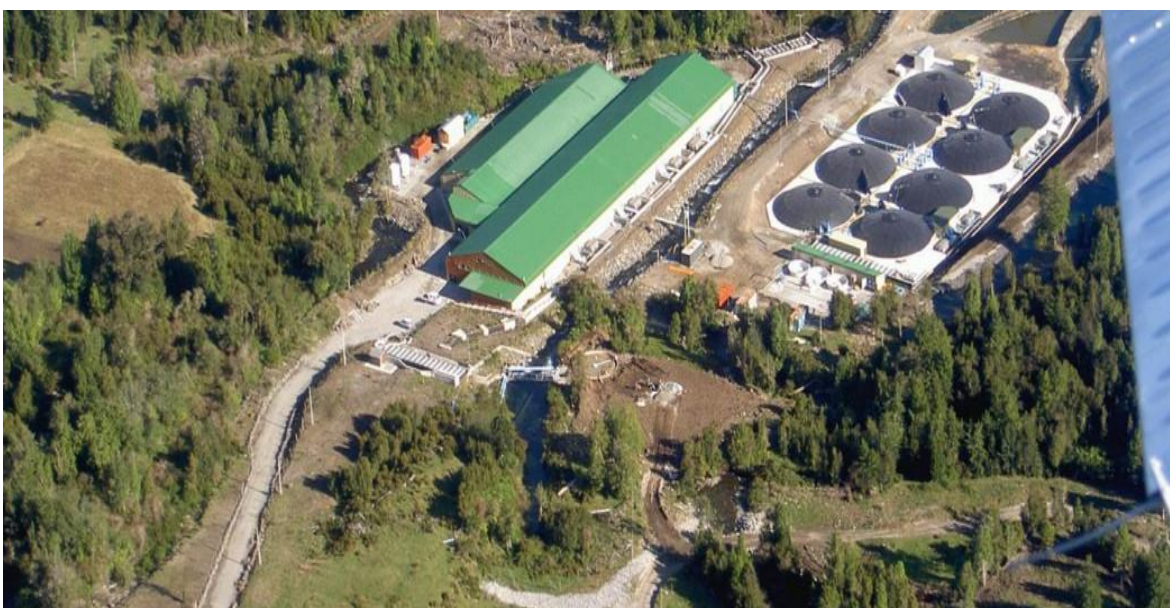
Imagen 8: Planta de la Empresa FrioSur, ubicada en el sector de Hornopirén, en tierras de la comunidad Rupulafken, sector que previamente correspondía a espacios alcereros de esta misma comunidad. Fuente: https://www.friosur.cl/
