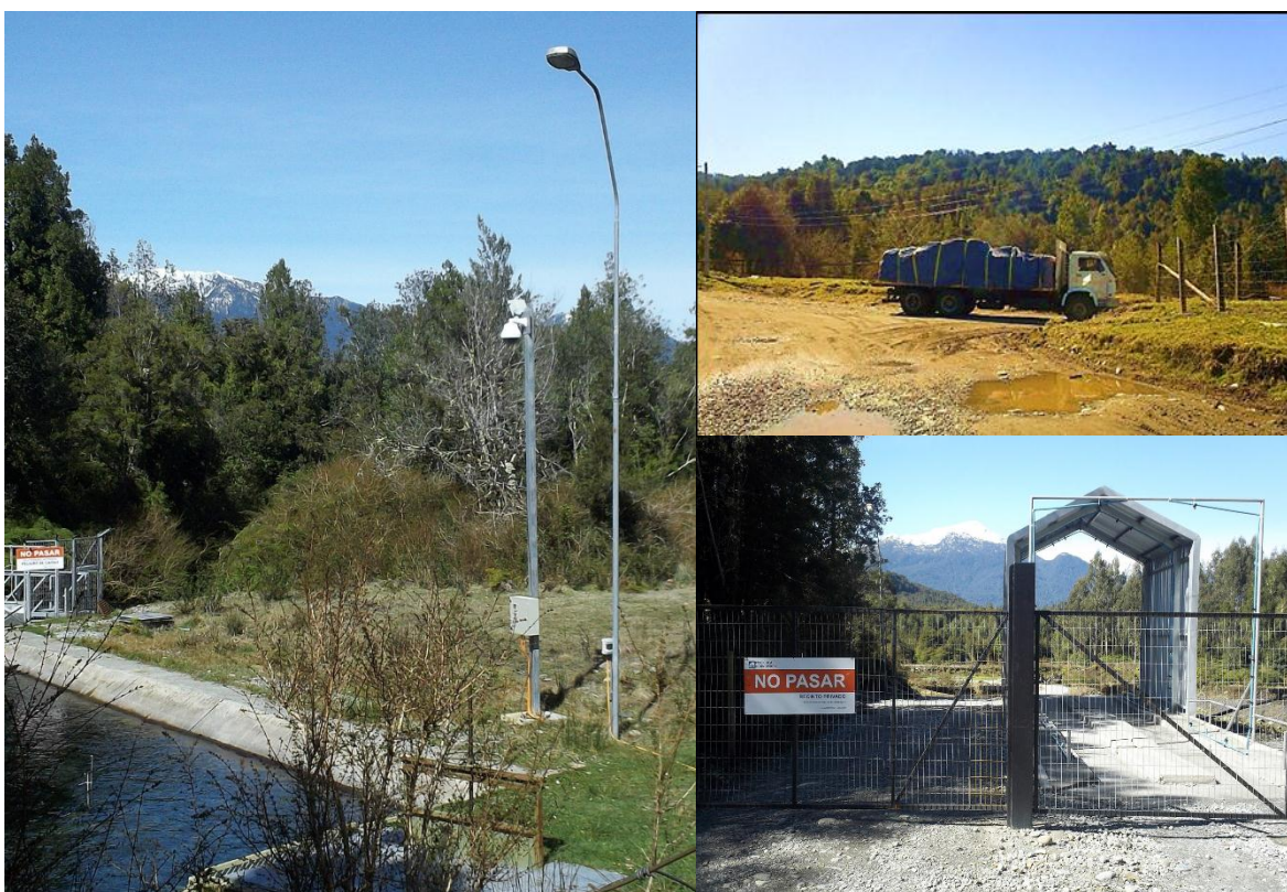
Imágenes 9,10 y 11: Imágenes que muestran las diferentes transformaciones espaciales desarrolladas por la instalación de la empresa: limitación del espacio con cercados y cámaras de seguridad y reutilización de huellas locales, como vías de camiones salmoneros. Fotografías tomadas por el autor.
