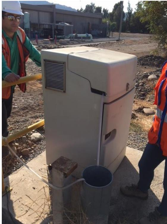
Figura 30. Fotografía del muestreador automático, localizado en la arqueta de salida de la planta el Trebal (efluente).
