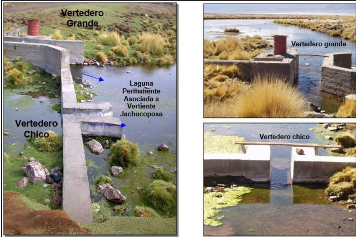
Figura 4-70: Fotografía de vertederos en estación CSW-2, Vertiente Jachucoposa
