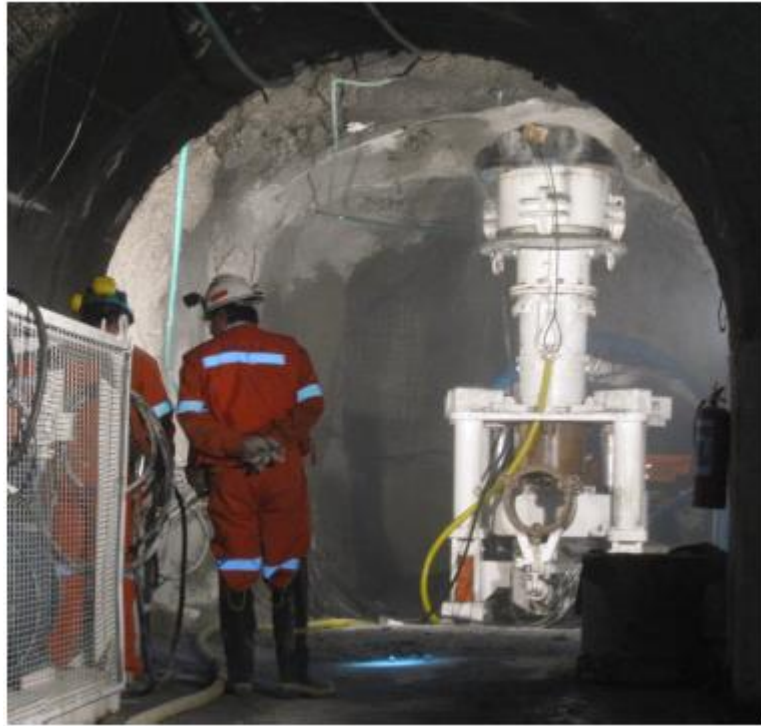
Figura 12: Perforación máquina Blind Hole. Fuente: Master Drilling 2018.
