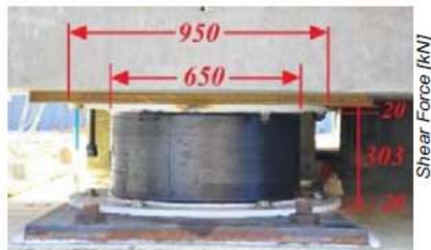
Figura 6-5: Imagen Aislador sísmico
