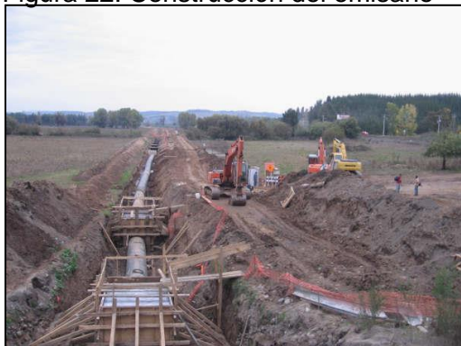
Figura 22: Construcción del emisario
