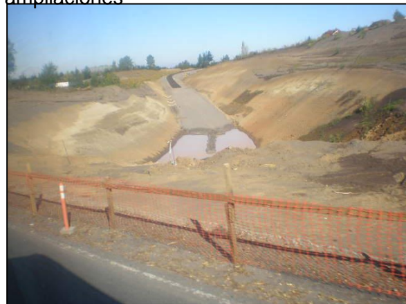
Figura 71: Vía férrea en reparaciones y ampliaciones
