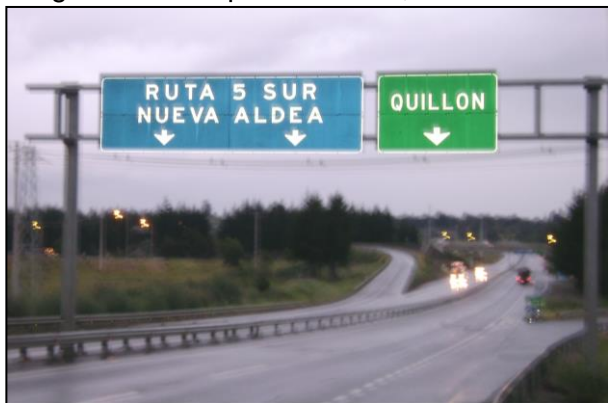
Figura 68: Autopista del Itata, cruce
