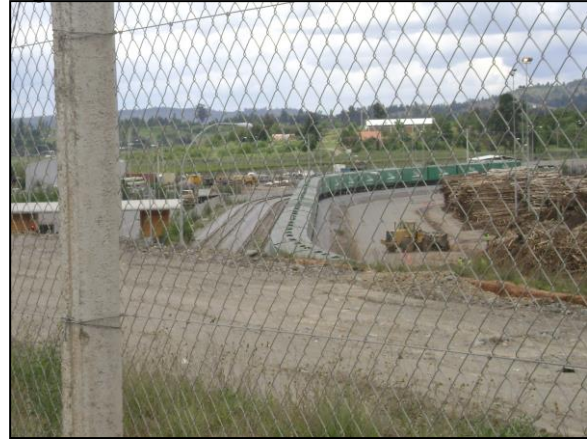
Figura 73: Trenes funcionando en el CFI
