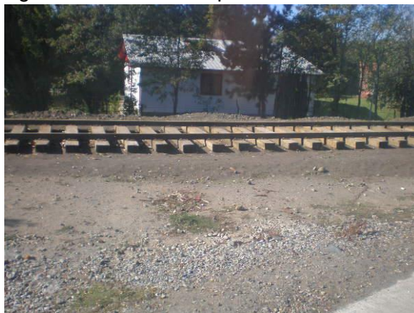
Figura 72: Vía férrea reparada
