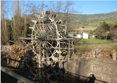
Azuda de madera, emplazada en el Canal Almahue. Artefacto hidráulico que ha permitido la supervivencia de la agricultura en el secano costero de Larmahue (IHP, 2013).
