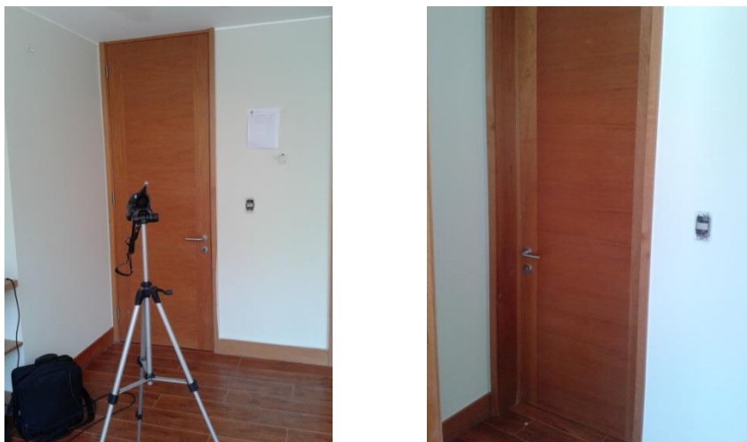
Figura 4-21 – Vista exterior e interior de la puerta ensayada.
