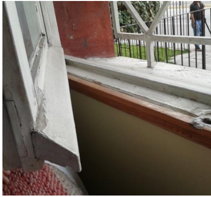
Figura 4-9 – Detalle de la terminación de ventana utilizada para el ensayo.
