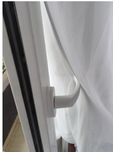
Figura 4-19 – Detalle del cierre de la ventana ensayada
