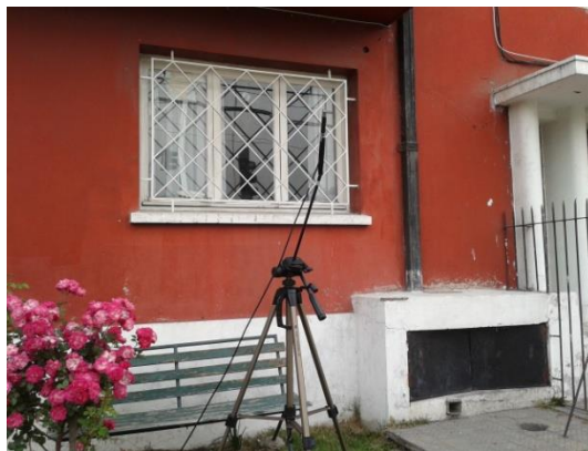
Figura 4-8 – Vista exterior de la fachada utilizada para el ensayo
