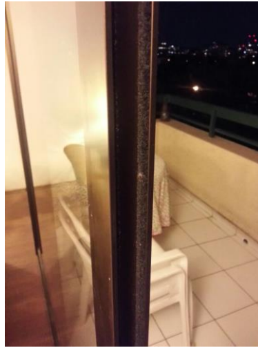
Figura 4-4 – Detalle cierre perimetral.
