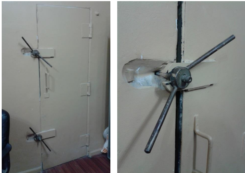
Figura 4-24 – A la izquierda vista exterior de la puerta de la sala reverberante, a la derecha detalle del sistema de cierre de la misma.
