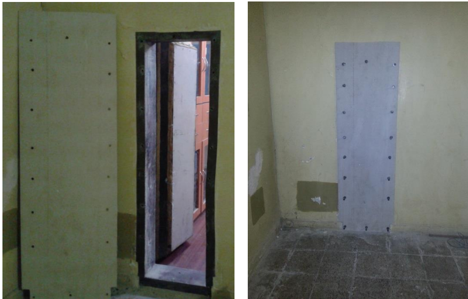
Figura 4-25 – A la izquierda el hueco donde se instala el panel reforzado con bandas acústicas y a la derecha, el panel instalado visto desde el interior de la sala reverberante.
