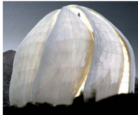
(b) Templo Bahai (Ingeniería estructural Carruthers Wallace, Patricio Bertholet, VMB, SIRVE)
