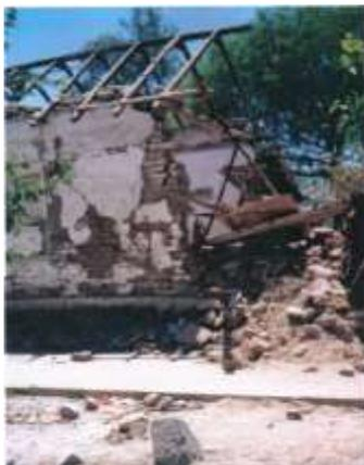
**Figura 35: COLAPSO DE MUROS EN UNA VIVIENDA DE ADOBE, EN LA CIUDAD DE PUNITAQUI.**
