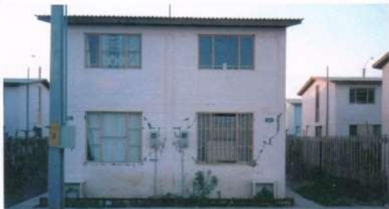
**Figura 36: GRIETAS EN VIVIENDAS SOCIALES CONSTRUIDAS CON ALBAÑILERÍA DE BLOQUES, UBICADAS EN LA PARTE ALTA DE OVALLE, HACIA LA SALIDA A LA SERENA.**
