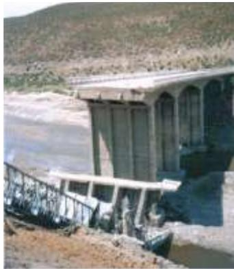
**Figura 40: COLAPSO DE UNA DE LAS CEPAS DEL PUENTE EL TENIENTE EN LA RUTA 5 NORTE, DEBIDO AL TERREMOTO DE PUNITAQUI. EN LA ESQUINA INFERIOR IZQUIERDA SE OBSERVA EL PUENTE MECANO PUESTO POR EL COLAPSO DEL ESTRIBO NORTE A CAUSA DE LOS TEMPORALES ANTERIORES AL TERREMOTO.**
