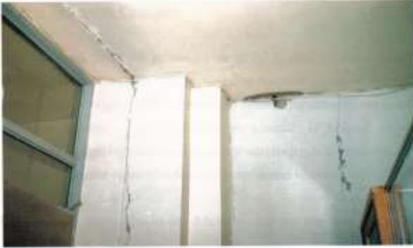
**Figura 43: GRIETAS EN JUNTAS DE CONSTRUCCIÓN EN EL HOSPITAL DE ILLAPEL.**
