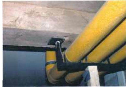
**Figura 44: ARRANQUE DE PERNOS EN EL HOSPITAL DE ILLAPEL.**
