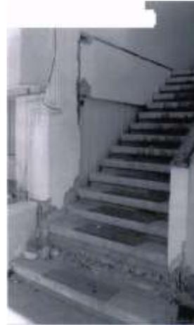
**Figura 46: DAÑOS EN UNA DE LAS ESCALERAS DEL HOSPITAL DE COQUIMBO (Astrosa, 2001).**
