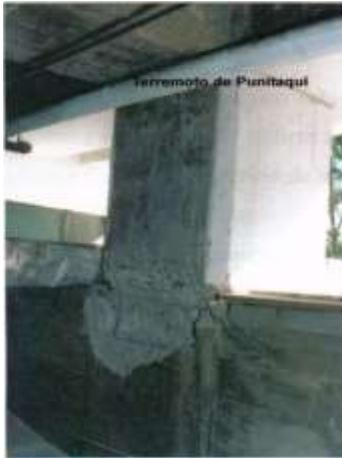
**Figura 45: DAÑO EN COLUMNA CORTA DEL PISO MECÁNICO EN EL HOSPITAL DE COQUIMBO (Astrosa, 2001).**
