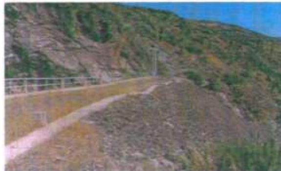
**Figura 42: DEFORMACIONES EN EL CORONAMIENTO DEL EMBALSE COGOTI (Pinos, 2000).**
