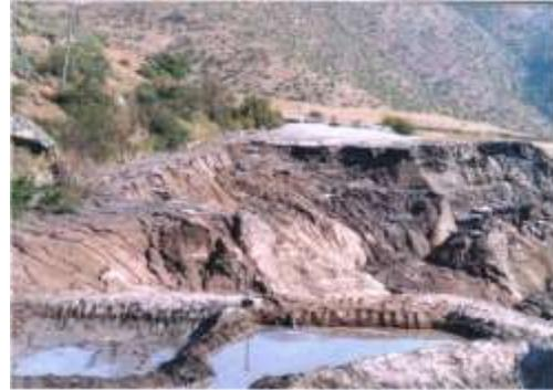
**Figura 52: COLAPSO DEL TRANQUE DE RELAVE,
