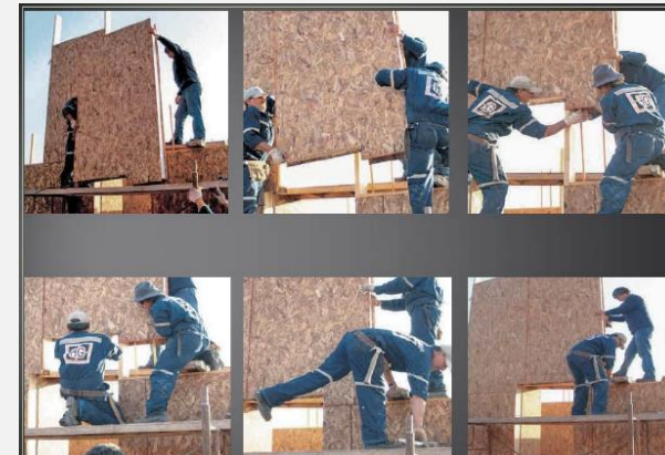
Fuente: Portal Ondac Construcción
