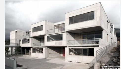
“Colegio Epullay Montessori” Fuente: Plataforma Arquitectura
