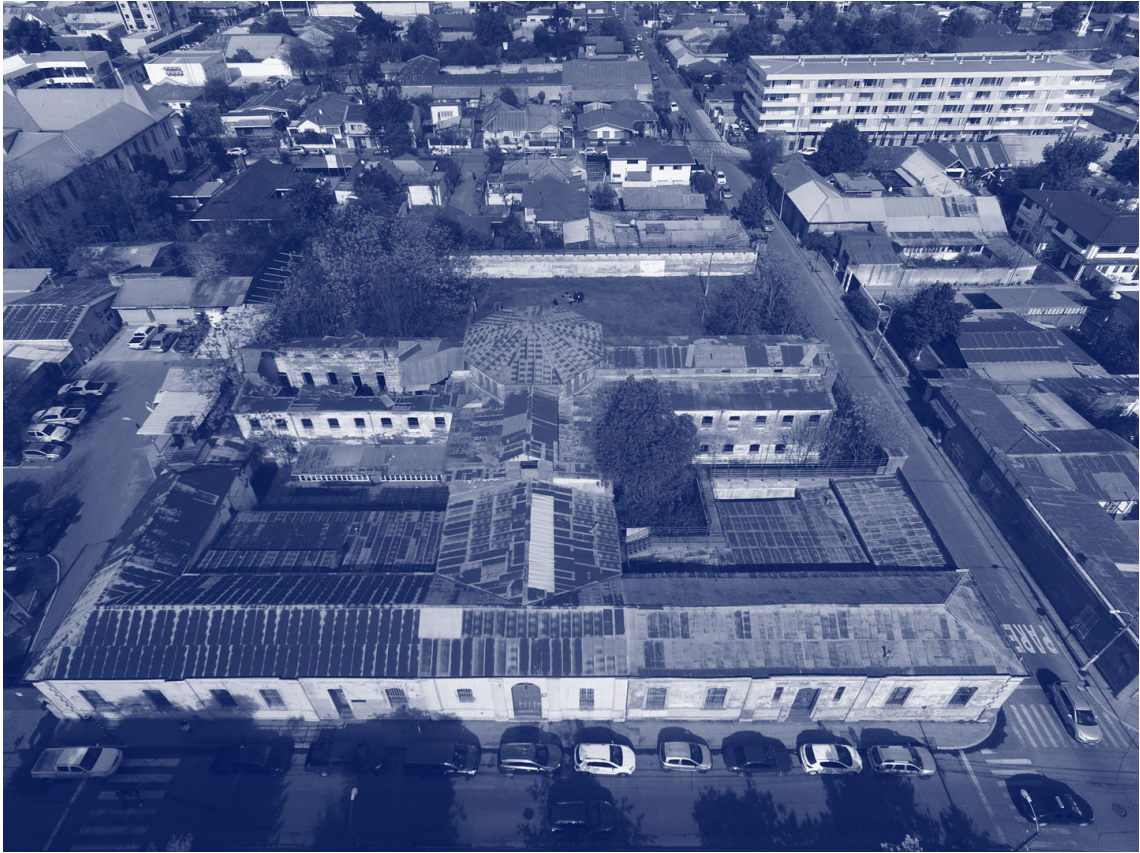
Figura 16. Vista panorámica actual
