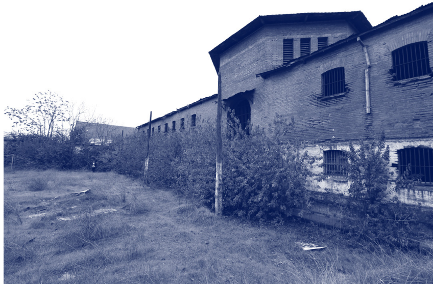
Figura 7. Fachada sur/ vista panóptico
