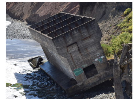
Silo 1 de Almacenamiento
