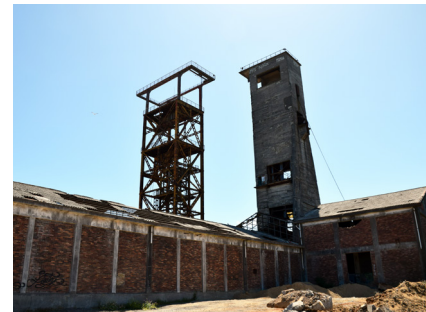
Cabrias de los Piques Carlos 1 y 2
