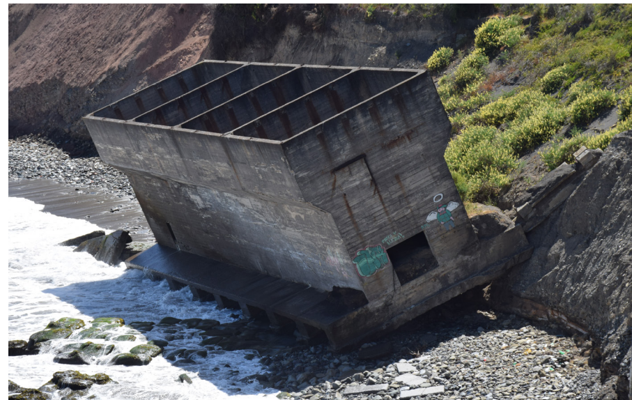
Foto actual ubicación Silo 1 de Almacenamiento (Fuente: Elaboración propia)
