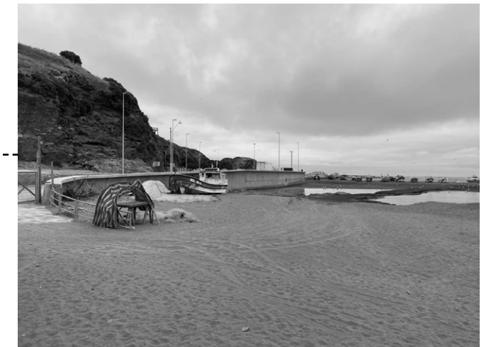
Figura 45: Imagen. Fuente: Fotografía propia
