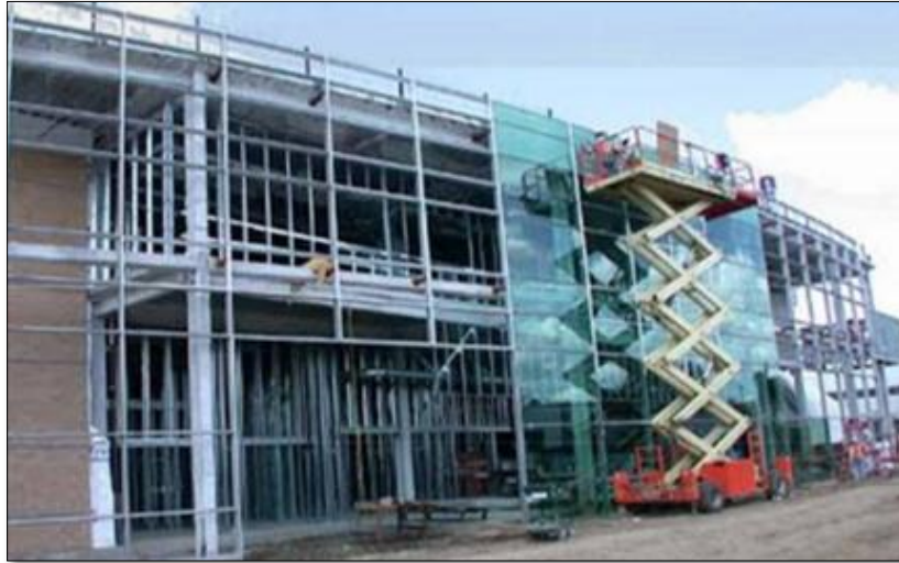
Ilustración 40: Muros cortina tipo Stick. (Fuente: Issuu.com/)
