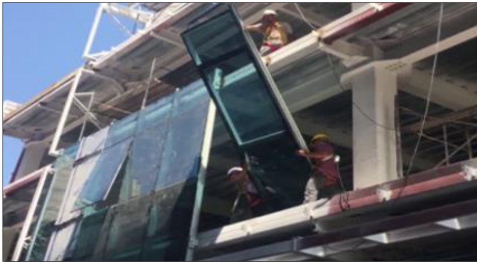
Ilustración 41: Muros cortina tipo Frame. (Fuente: issu.com/)
