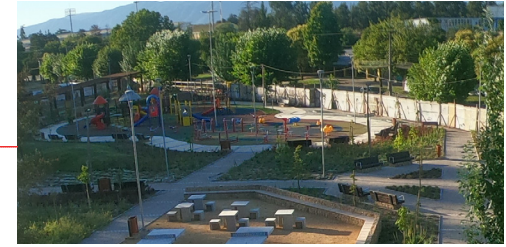
Parque MINVU [en construcción] (2020) Fuente: Elaboración propia
