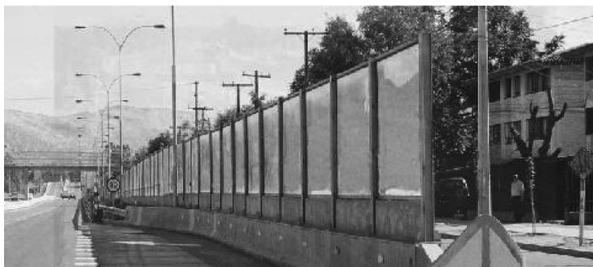
*Fig. 2.- Una de las medidas paliativas para el ruido de transporte, barreras acústicas en la Comuna de Santiago. Fuente: Allbiz, sf.*
