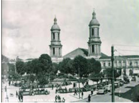
Captura de la Catedral del Obispo Salas previo a la demolición de sus torres tras el terremoto de 1939 (Fuente: El Concepción de Antaño )
