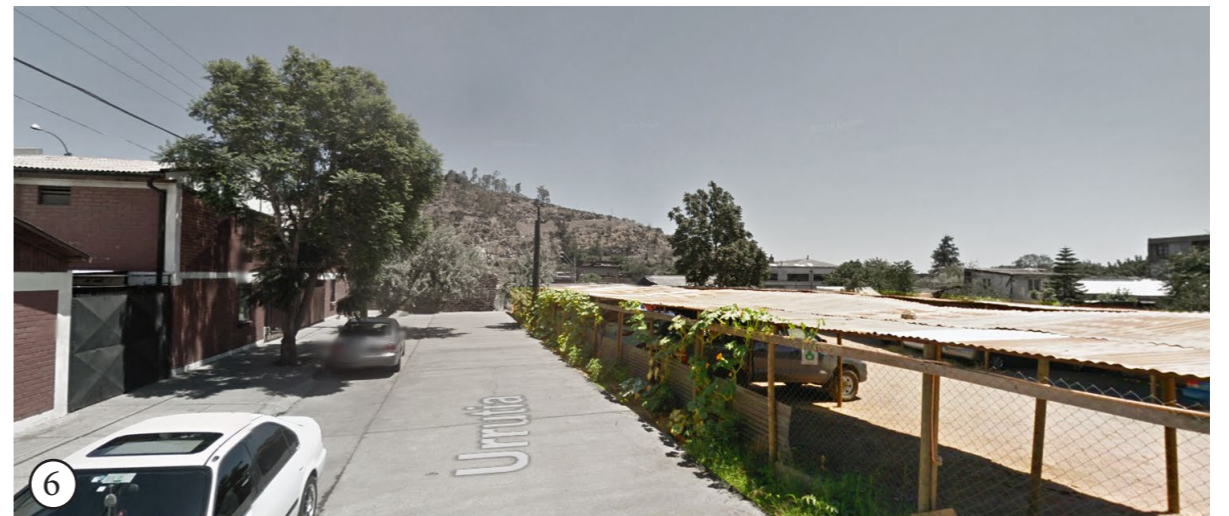
Figura 49 - 54. Imágenes del estado actual del sitio. Fuente imágenes: Elaboración propia en base a Google Maps.
