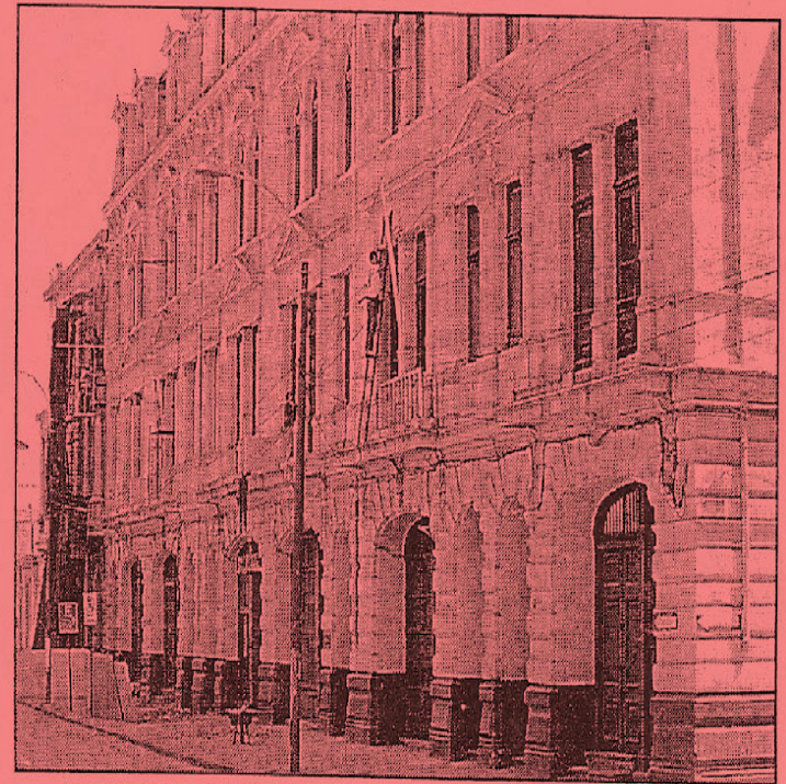
DEMUELEN ANTIGUO EDIFICIO PORTEÑO.— Este antiguo edificio manzana, ubicado en el cuadrante comprendido por las calles Brasil, Edwards, Blanco y Carrera, desaparecerá completamente, una vez que la empresa de demoliciones de Mario Porzio termine de realizar su trabajo, el que inició la semana pasada.
