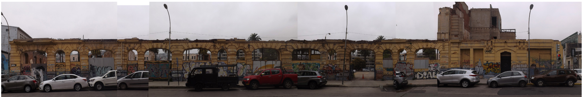
Levantamiento de fachada Calle Blanco / Norte Fuente: Elaboración propia. (2020)
