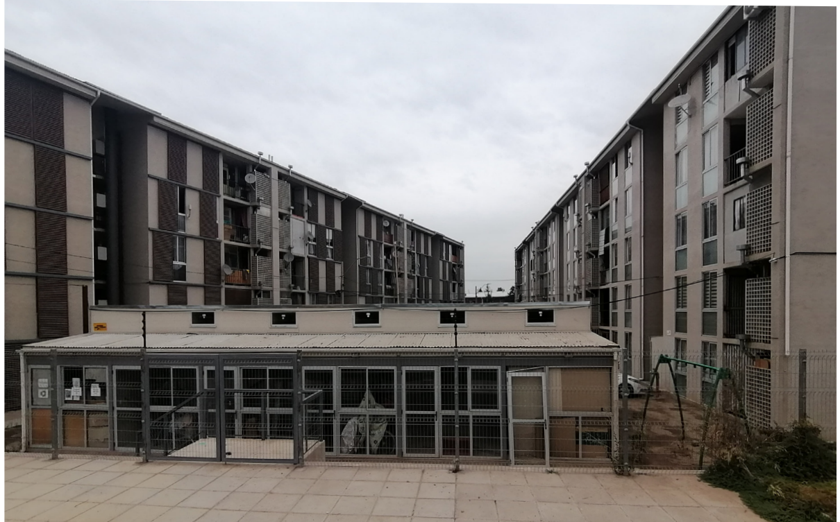
Foto N° 2 .Locales comerciales Portal La Florida. Registro Propio.
