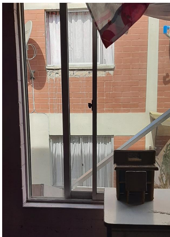
Fig. 108 Imagen: ventana dormitorio segundo nivel, vivienda caso 1 (Fuente: Elaboración propia)
