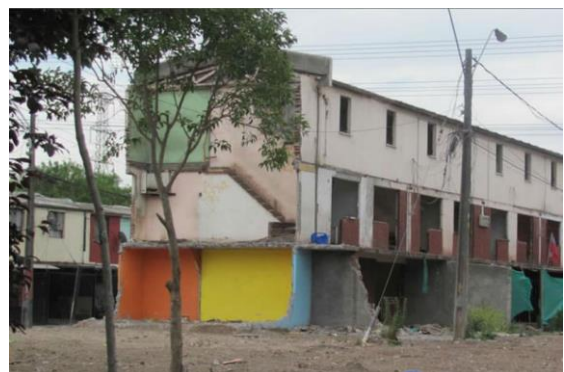
Fig. 61 Imágenes: Vista demolición Conjunto ex Viñitas (Fuente: socioher.cl)
