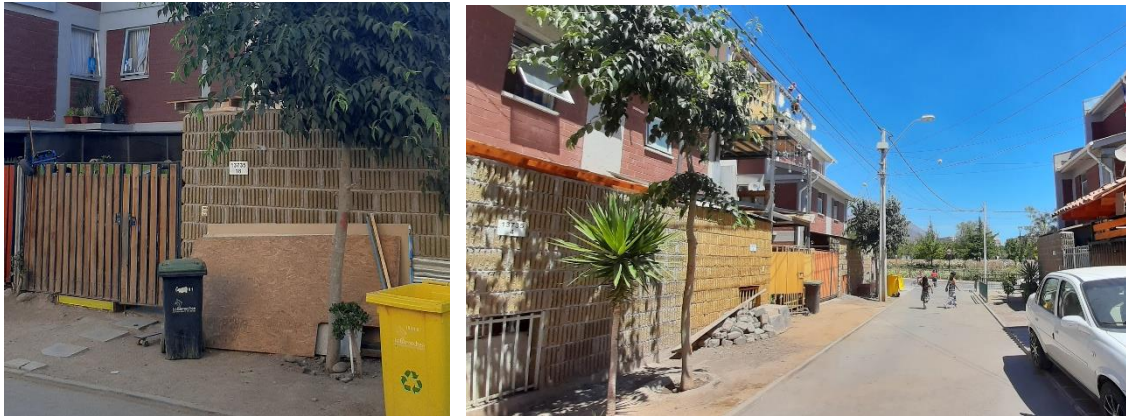
Fig. 86 Imágenes: Situaciones de acumulación de escombros en conjunto habitacional (Fuente: Elaboración propia)
