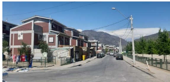
Fig. 96 Imagen: vista a fachada del conjunto (Fuente: Elaboración propia)
