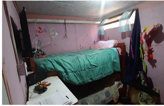
Fig. 124 Imagen: ventana dormitorio ampliación 1 nivel, vivienda caso 2 (Fuente: Elaboración propia)
