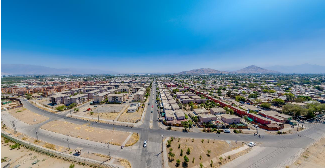
Fig. 170 Imagen: Vista aérea Conjunto Habitacional Lomas del Prado (Fuente: Elaboración propia)
