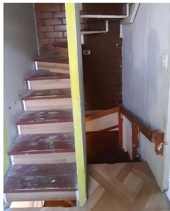
Fig. 97 Imagen: escalera segundo nivel, vivienda caso 2 (Fuente: Elaboración propia)
