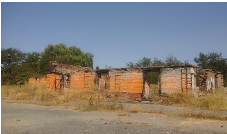
Foto N°4: Ex estación Requegua (Oscar Araya, 2020)
