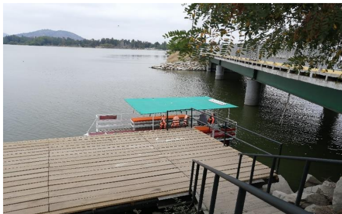
Foto N°24: Embarcadero Puente El Durazno, Lago Rapel (Oscar Araya, 2021)
