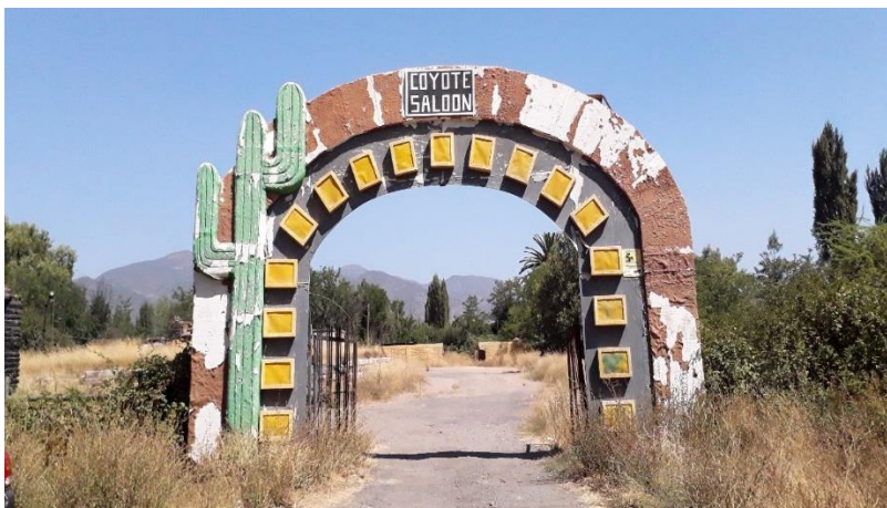
Foto N°5: Entrada ex estación Requegua (Oscar Araya, 2020)
