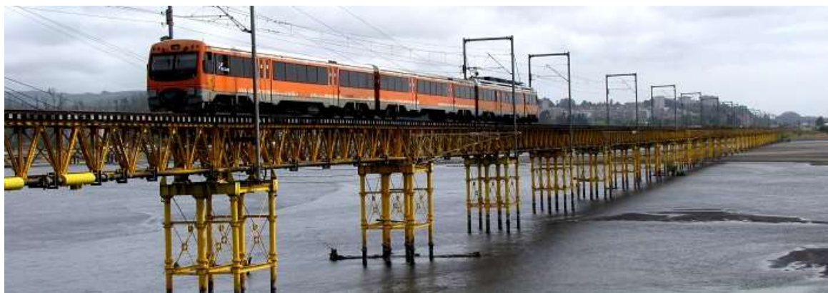
Imagen 9: Puente ferroviario Concepción – San Pedro de la Paz. Fuente: pág. www.datos.gob.cl , 2020
