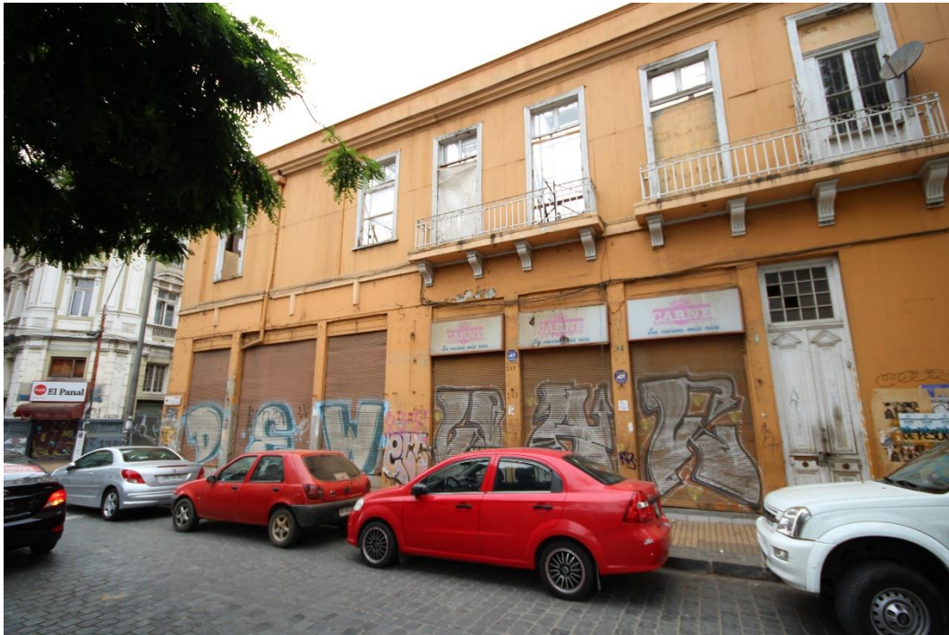
Figura 46 – Exterior del edificio donde se emplaza el Emporio Echaurren, durante su remodelación. Fecha: 15.02.2018. Autoría propia.
