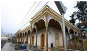
Figura 19: Estación Ferroviaria San Bernardo .
