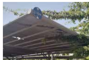
Figura 162: Límite altura 2.1m estacionamiento centro comercial.
