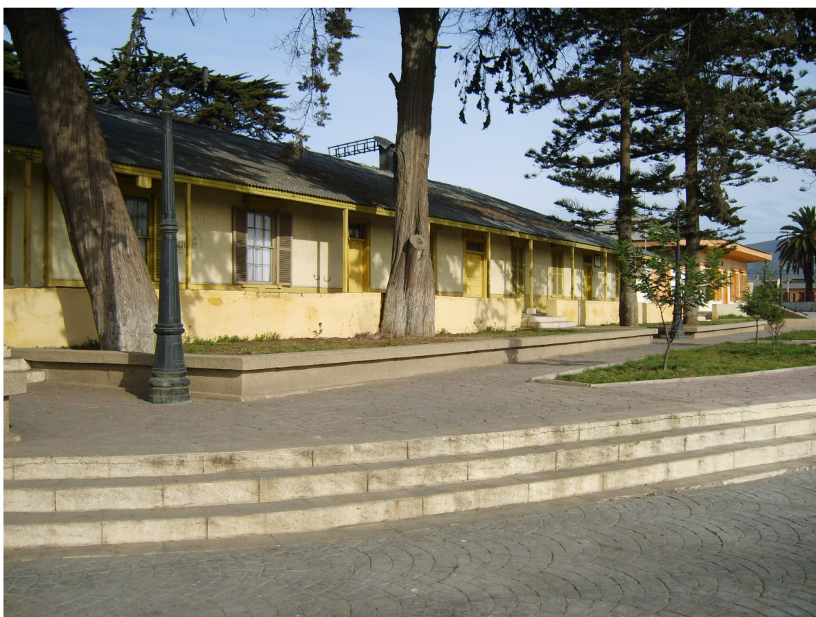
[Figura 57]. Vista MH Casa de Administración y laboratorio químico. Disponible en http://panoramio.com
