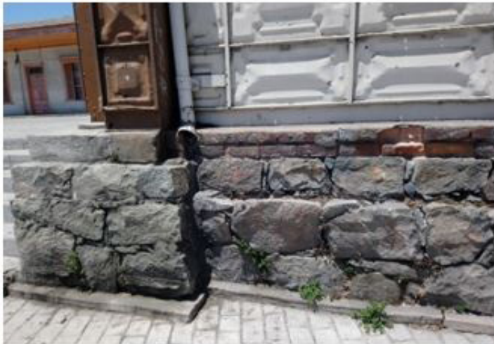
[Figura 158, 159, 160 y 161]. Vestigios ladrillo refractario en calle Urmeneta, Archivo CMN (2020). Ladrillo refractario en fundaciones Iglesia de Guayacán. Fotografías propias.
