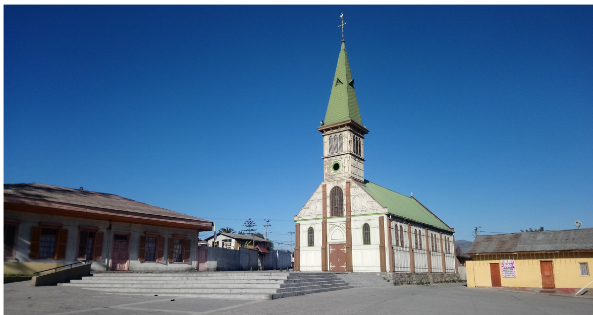
[Figura 56] Vista general de la Iglesia de Guayacán. Fotografía propia
