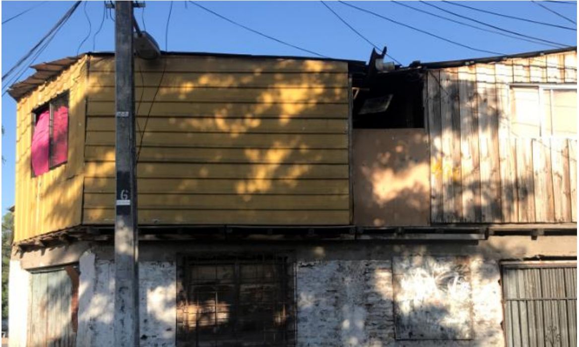
Fotografía 9. Ampliación segundo piso detalle revestimiento. Fuente: Registro propio
