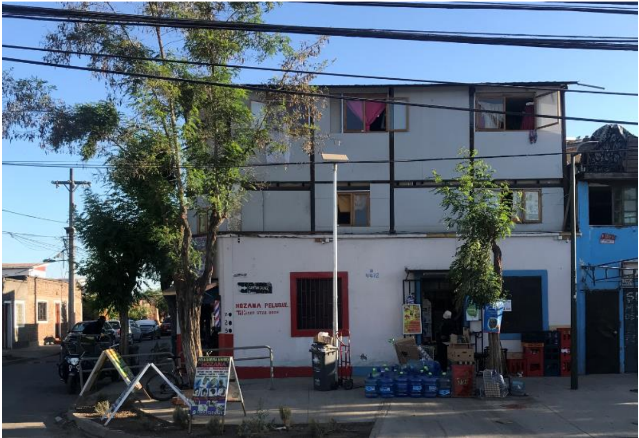
Fotografía 6. Ampliación 2 pisos. Fuente: Registro propio
