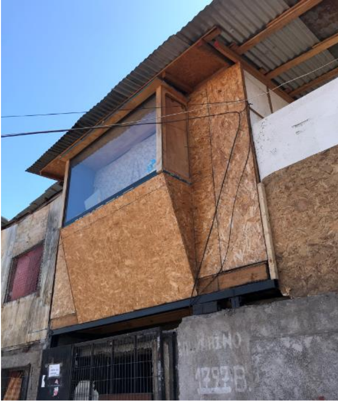
Fotografía 7. Ampliación segundo piso, detalle ornamental ventana. Fuente: Registro propio
