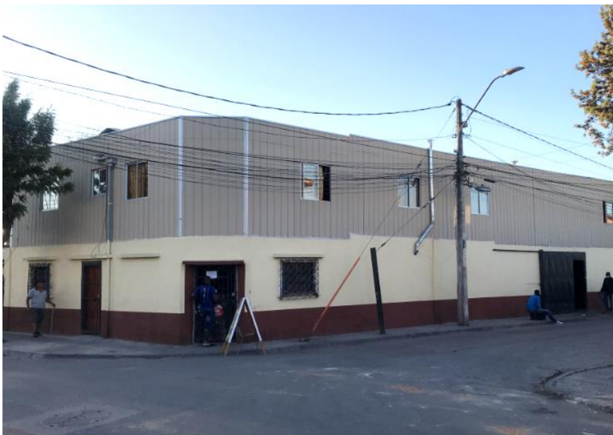
Fotografía 12. Ampliación segundo piso, detalle revestimientos y colores. Fuente: Registro propio
