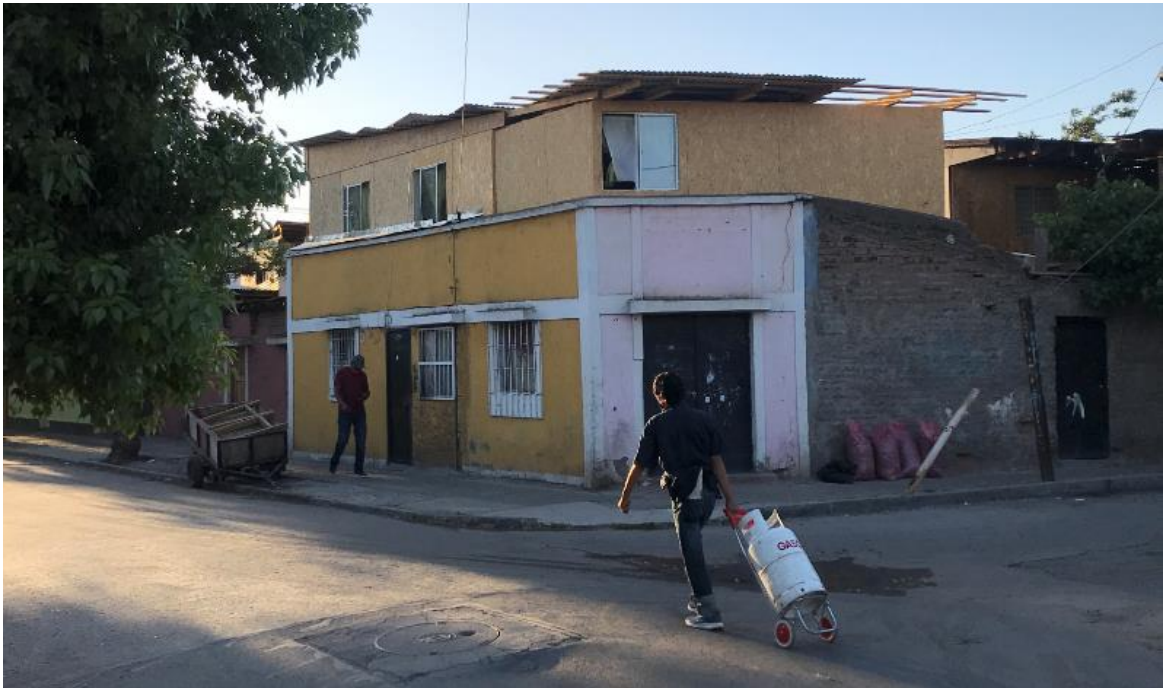
Fotografía 10. Ampliación segundo piso OSB, cubierta sin terminar. Fuente: Registro propio
