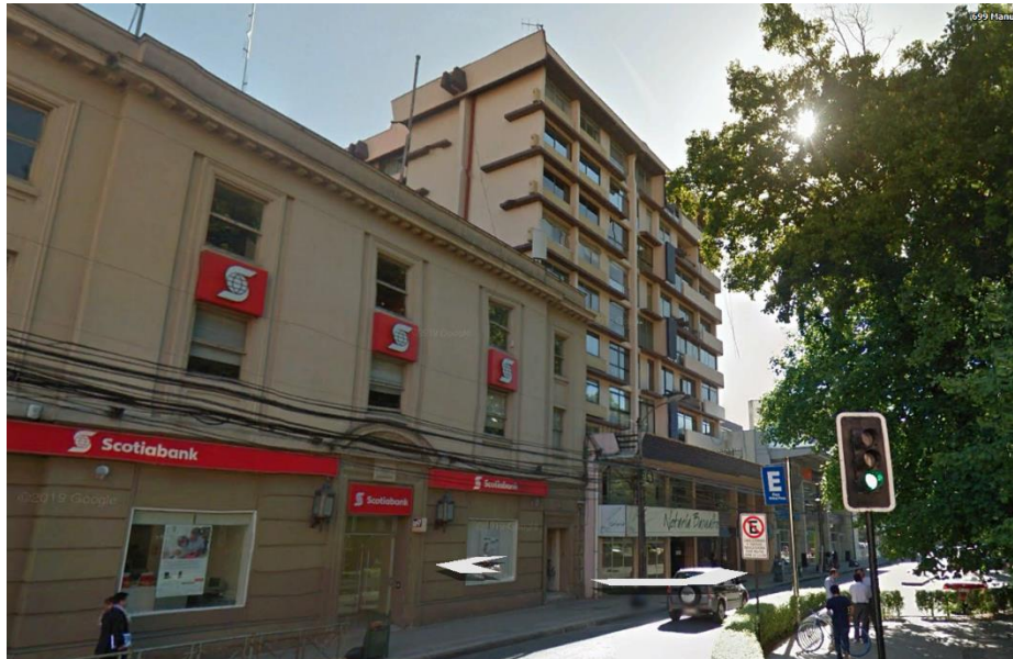
Edificio construido el año 1968 en calle Varas. Ubicado frente a Plaza de Armas de Temuco. Vista desde esquina con Bulnes.
