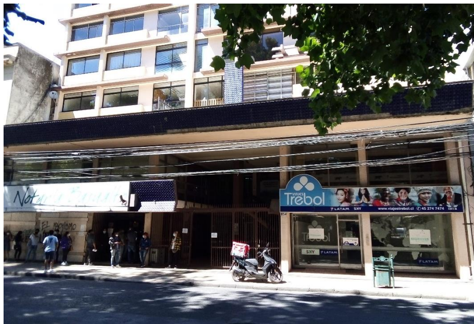
Vista de placa comercial y acceso a Galería.
