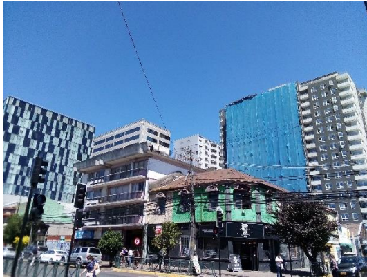
Vista desde calle Claro Solar hacia el poniente
