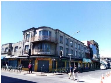
Edificio esquina calles Aldunate con Rodríguez, esquina nor-oriental de mercado
