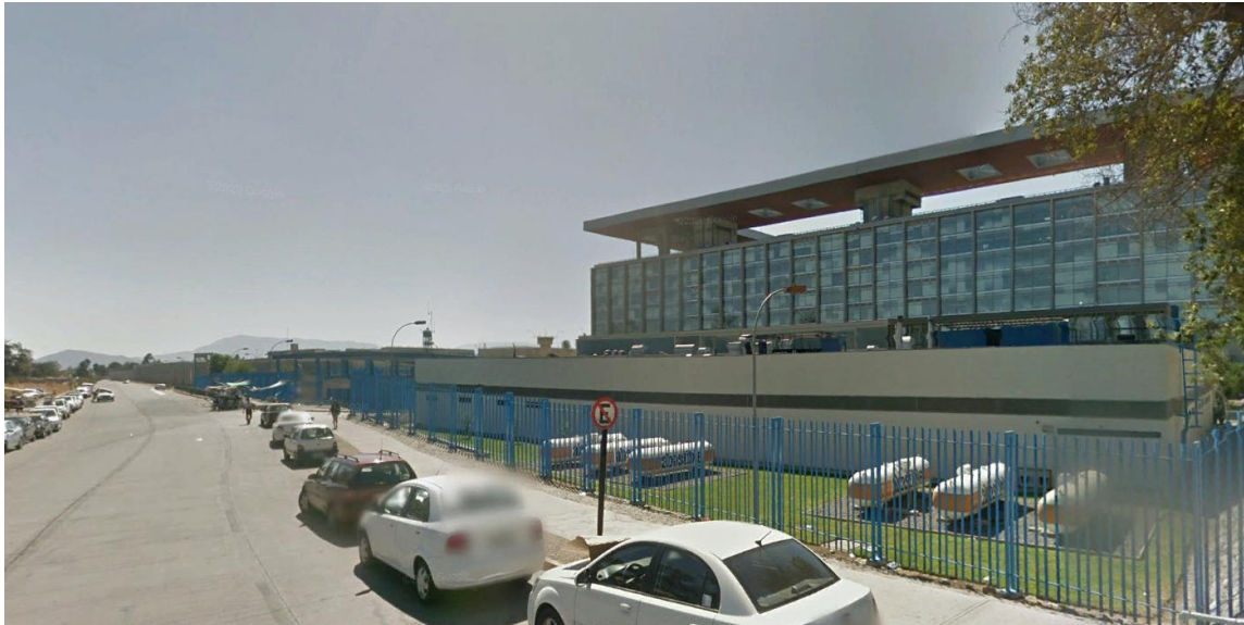
Figura 7 Vista hacia el Centro de Justicia de Santiago y la Cárcel Santiago 1 a su lado desde la calle Centenario. Fuente: Google Street View ([2014] 2021).
