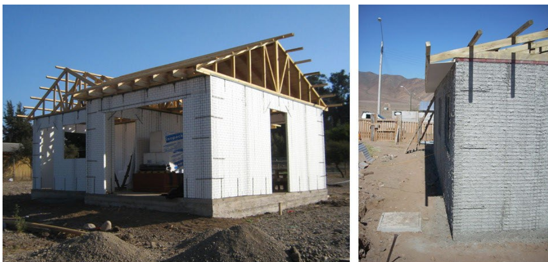
Fig. 6 Vivienda social en paneles “Covintec”. Fuente: covintec.cl.
