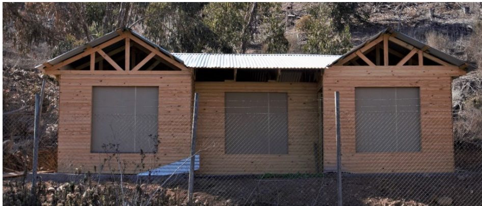
Fig. 9 Vivienda prefabricada emplazada (La Serena, 2021).
