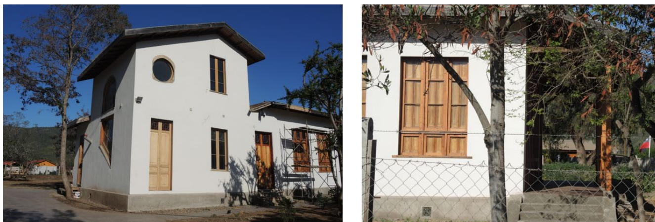
Fig. 41 Antigua escuela rural de La Ligua, MH, localidad de la Higuera. Ejemplo de valorización del patrimonio local en tierra. Edificio republicano de fines del siglo XIX, tabiquería de madera rellena de adobillo.
