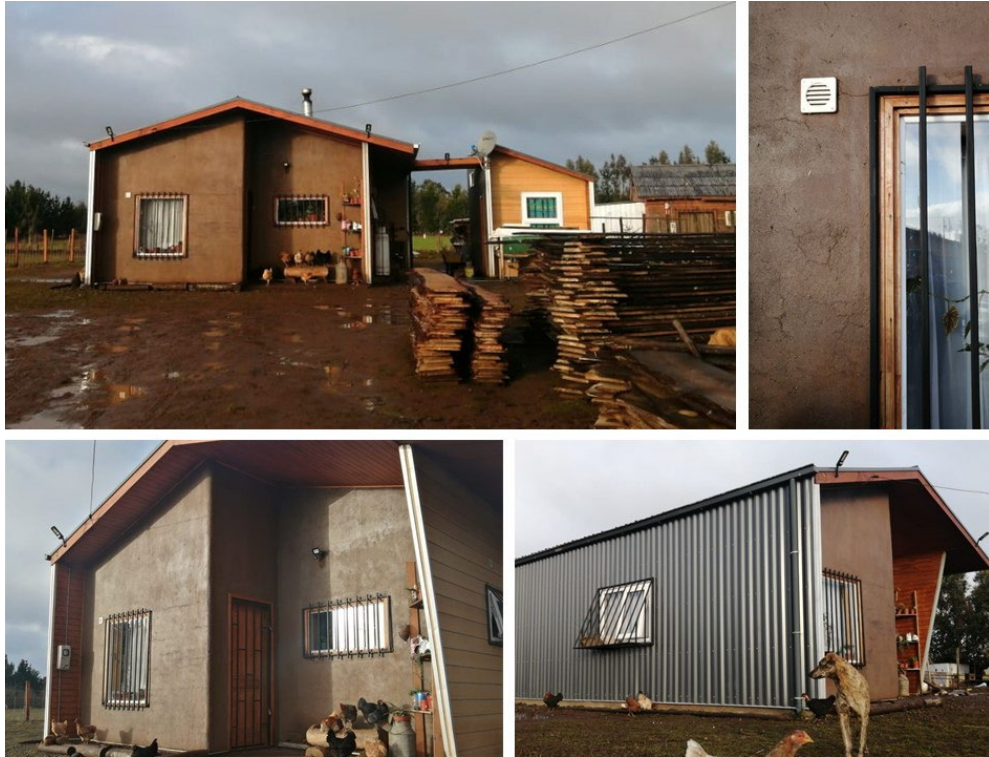
Fig. 13 Vivienda social “Proyecto origen” en Araucanía, 2019; muros en quincha seca con revoque de barro y planchas de zinc; constructora: Santa Magdalena y consultora Sembra, 2019. Foto de Santiago Cárdenas.
