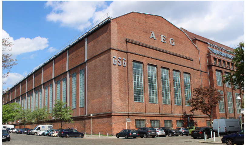
Figura 2. Montagehalle für Großmaschinen , AEG, Berlín. Arquitecto Peter Behrens, 1912. Fotografía: Rodrigo Vera Manríquez.
