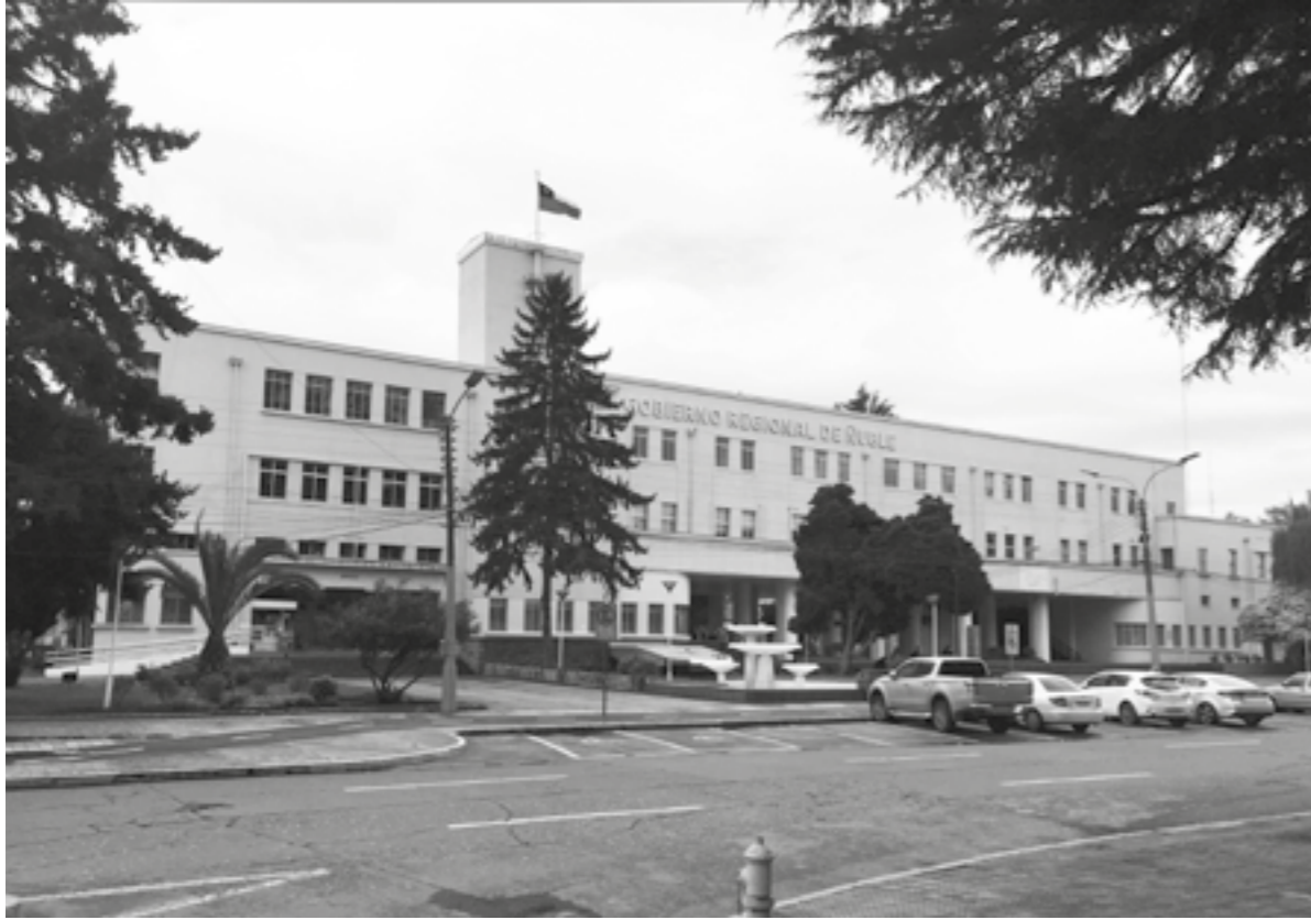
Edificio del Gobierno Regional de Ñuble. Autor: Rodrigo Vera Manríquez.
