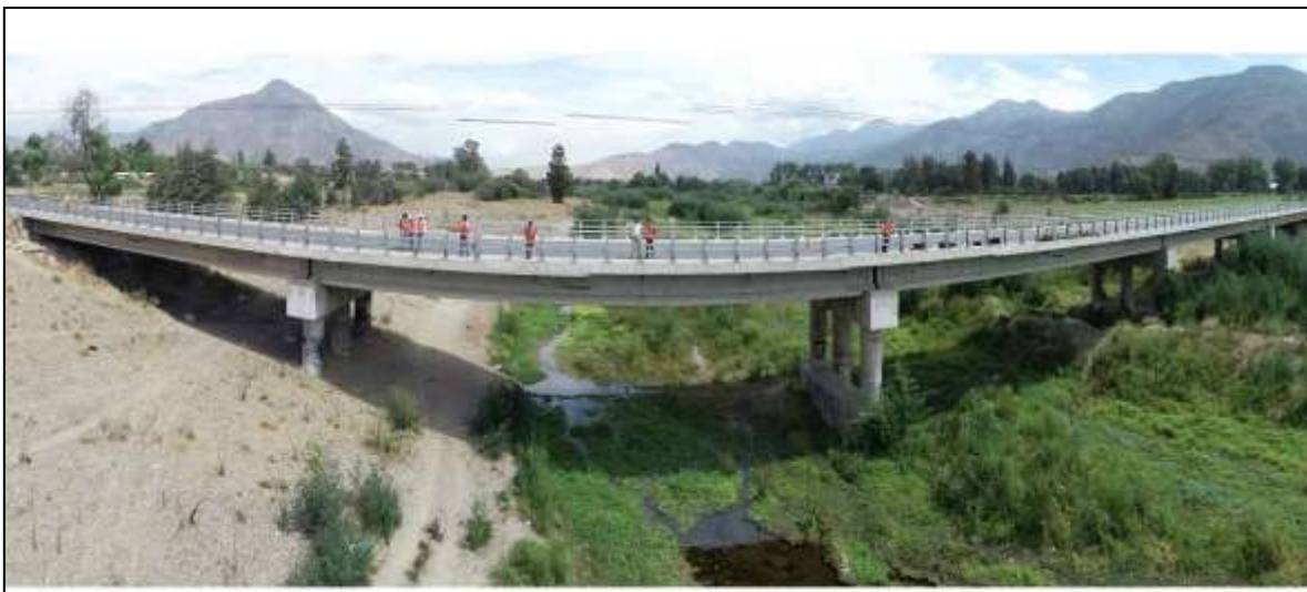
Figura 53: Puente Águila Norte.
