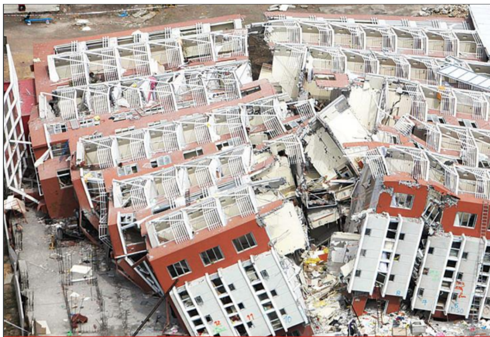
Figura 11.21: Terremoto del Maule, Cauquenes 2010, caída de edificios, (Ortiz, 2012)
