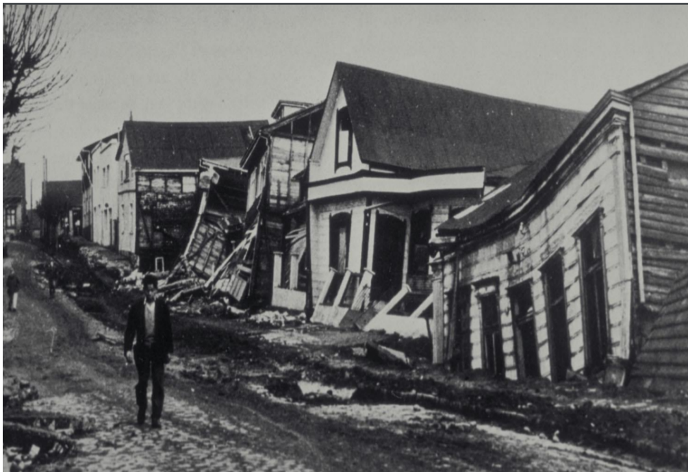
Figura 11.20: Terremoto de Valdivia 1960, infraestructura 2, (Ortiz, 2012)
