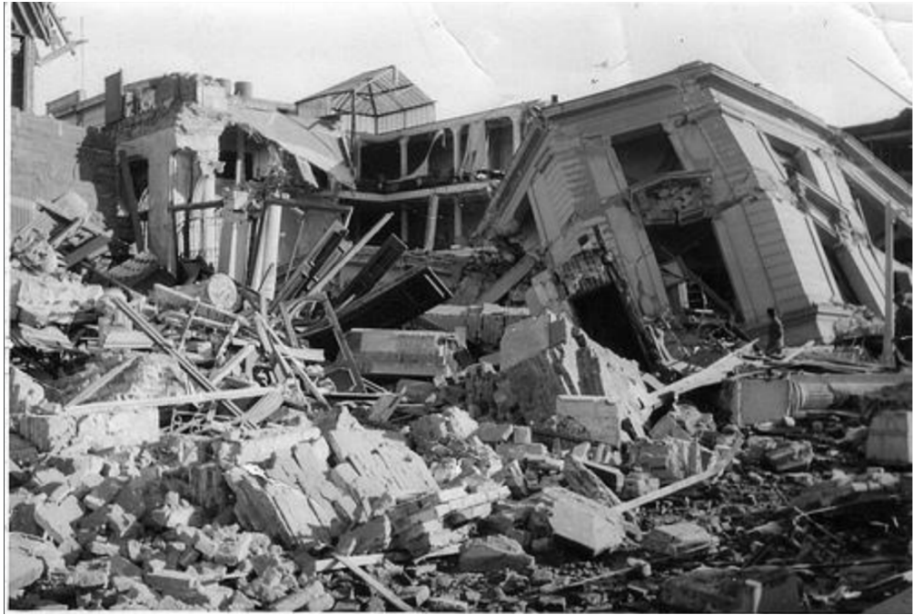
Figura 11.19: Terremoto de Valdivia 1960, infraestructura 1, (Ortiz, 2012)
