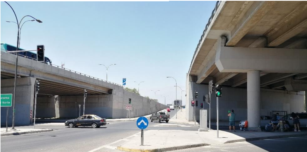
Ilustración 33 Al lado izquierdo acceso hacia independencia, al lado derecho el acceso a Santiago, Elaboración propia (2020)
