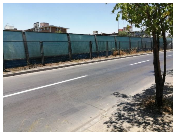
Ilustración 2 Situación actual Autopista Central separando Población Juan Antonio Ríos (2020) Alejandro Soto
