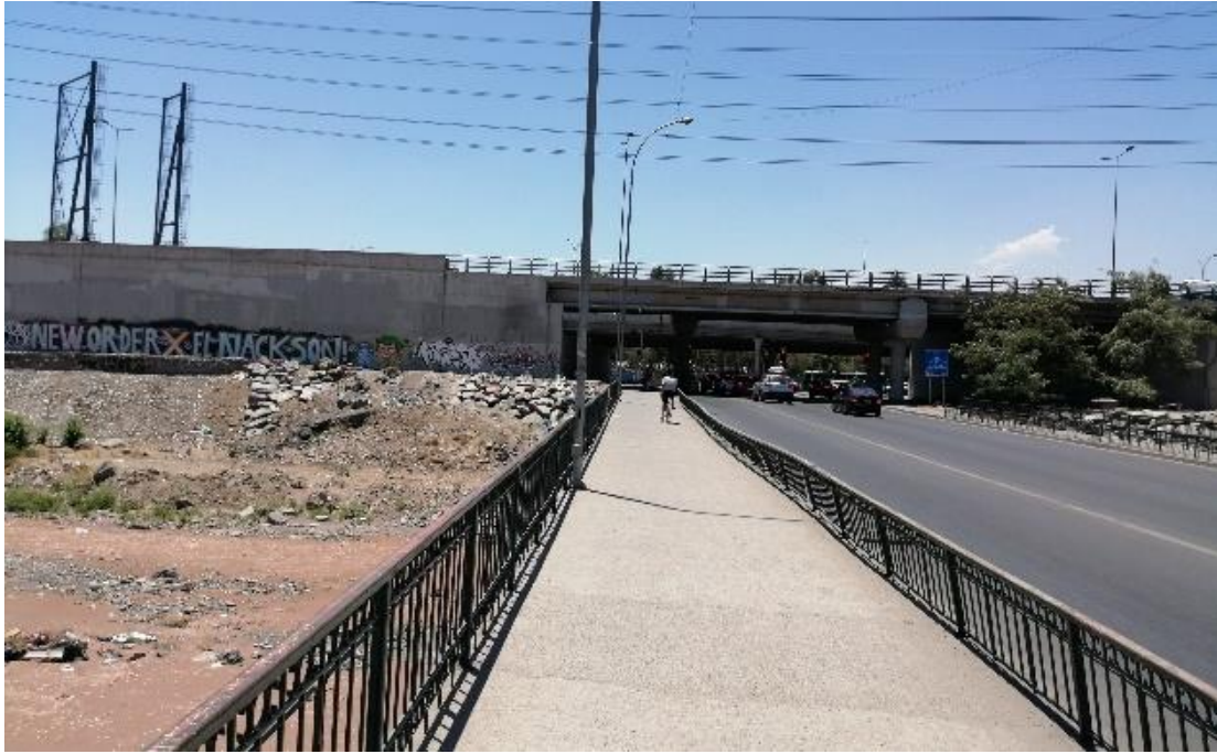
Ilustración 37 Puente Bulnes vista hacia autopista. Elaboración Propia. (2020)
