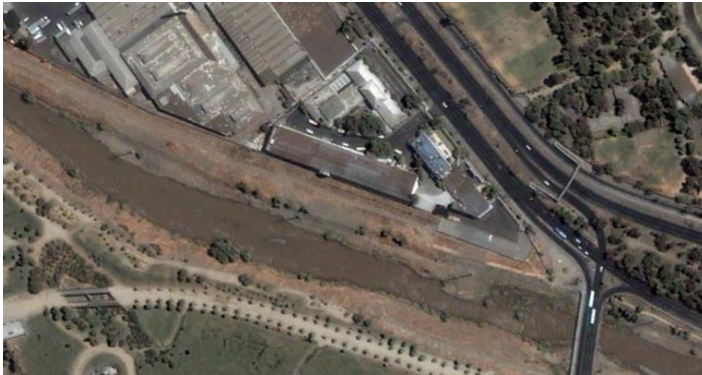
Ilustración 23 Imagen Satelital Obras de Construcción Costanera Norte. fuente Google Earth (2004)
