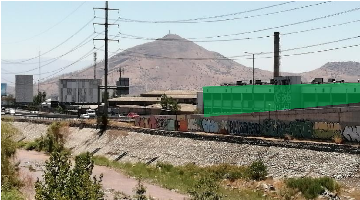
Ilustración 54 Vista edificio textil Hirmas desde Parque de los Reyes, Elaboración Propia (2021)
