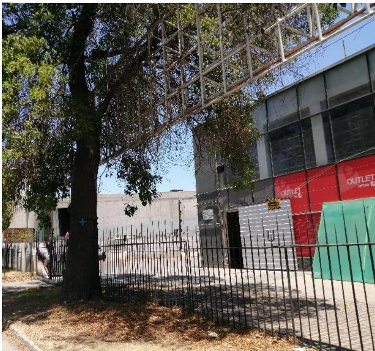
Ilustración 53 Vista Entrada Outlet La Polar, Elaboración Propia, (2020)
