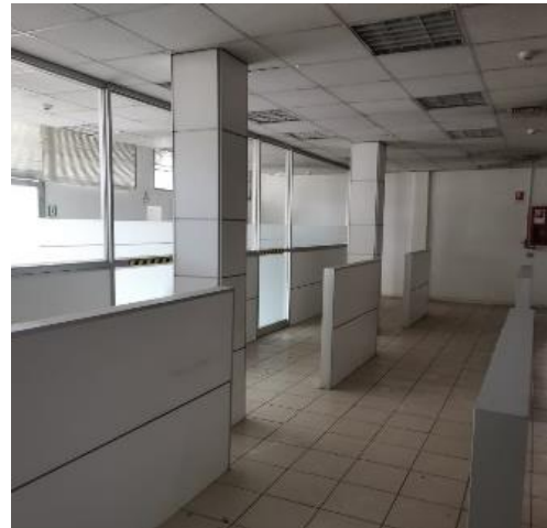
Ilustración 59 Oficinas remodeladas, Foto Verónica Sagredo (2020)
