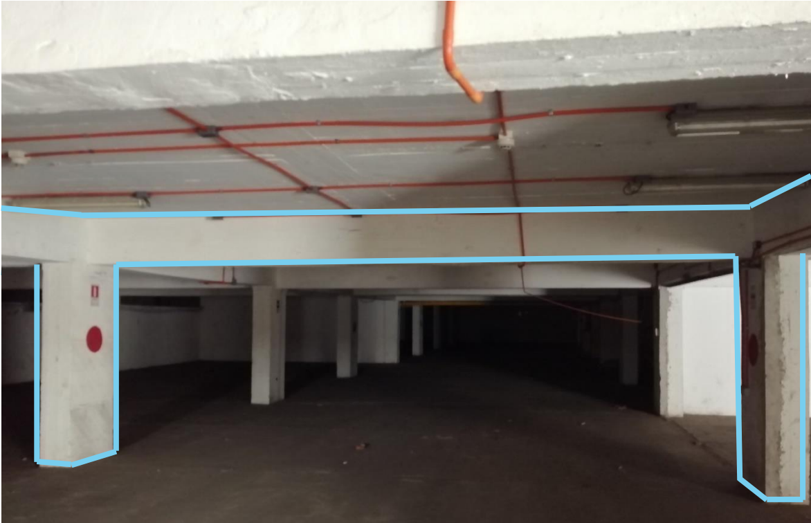
Ilustración 69Foto Estacionamiento subterráneo edificio Hirmas, destacando elementos estructurales (2021)
