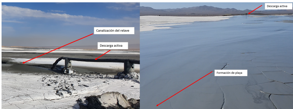
Figura 2.7: Deposición de relaves espesados, canalización y formación de playa.
