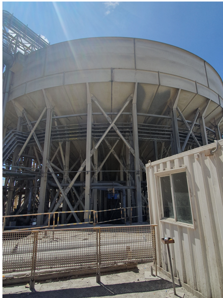
Figura 2.3: Espesador de relaves del tipo DCT (Deep Cone Technology). Minera Centinela.
