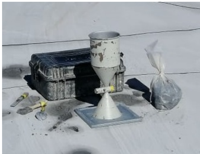
Figura 4.14: Ensayo de cono de arena a la capa previa en día 1.
