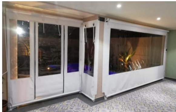
Figura 5: Cierre de Terraza con mecanismo de enrollado por manivela.
