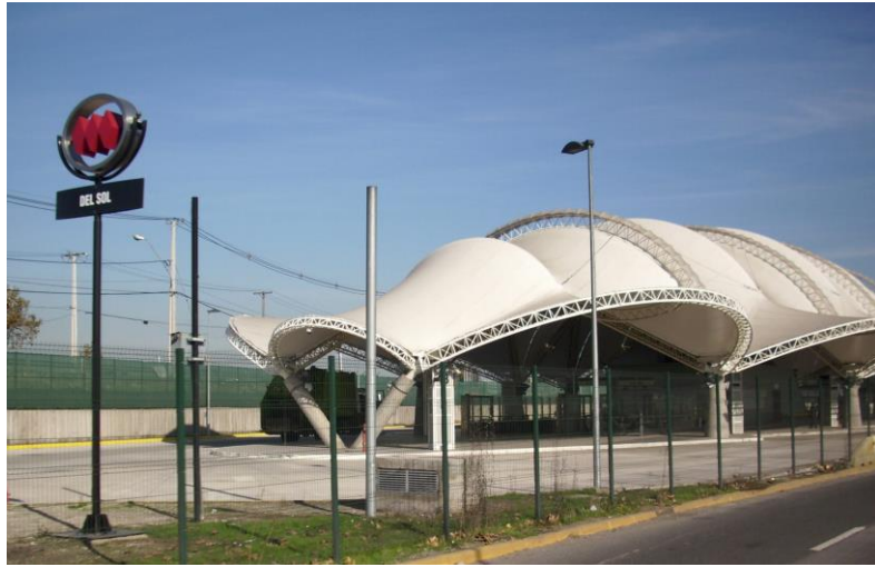
Figura 11: Imagen de una tenso-estructura industrial.
