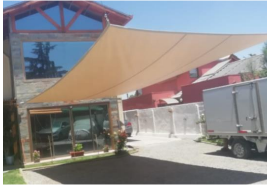
Figura 6: Carpa Tensada con cables de acero
