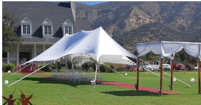
Figura 9: Carpa Araña de 6x12 con 3 pilares y 8 tensores.
