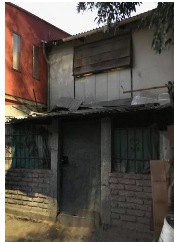
Figura 10: Vivienda progresiva, situación original de Villa Nacimiento
