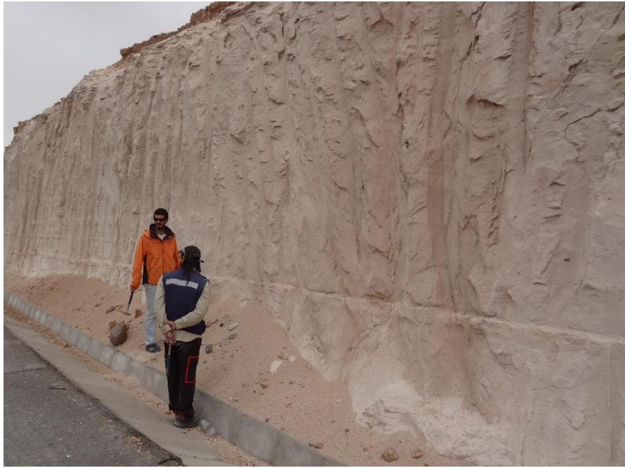
Figura 17. Nivel 4 definido en la Figura 16. Depósito macizo color gris rosáceo. Corresponde a un talud en ruta Sector Copaquilla.
