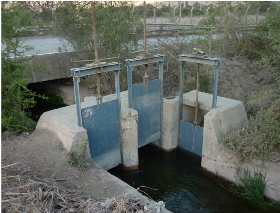
Figura 3.6: Obra de entrega (Toma Pedregal) – Km 2+971
