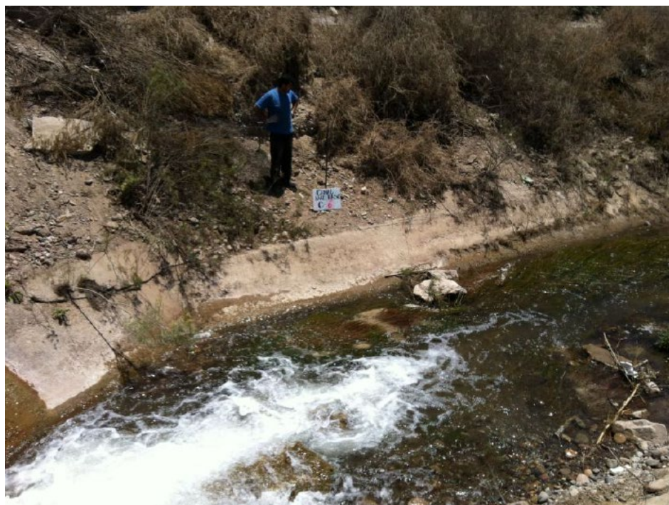
Figura 8.1: Calicata N°6, aguas debajo de caída N°8
