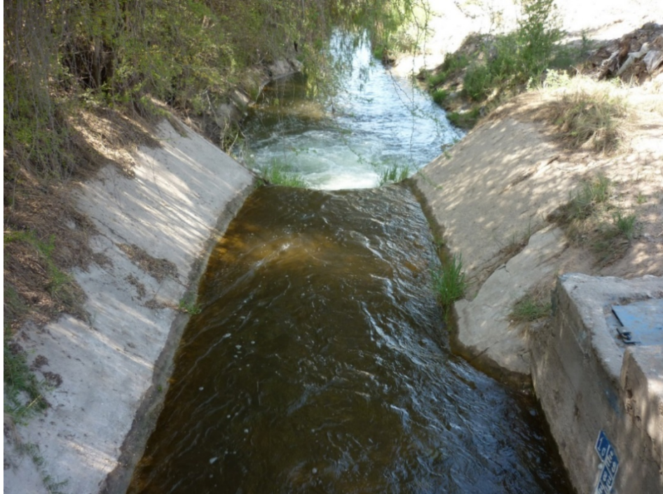
Figura 3.3: Caída N°1, Km 0+322 – Caída típica de 3 m de altura
