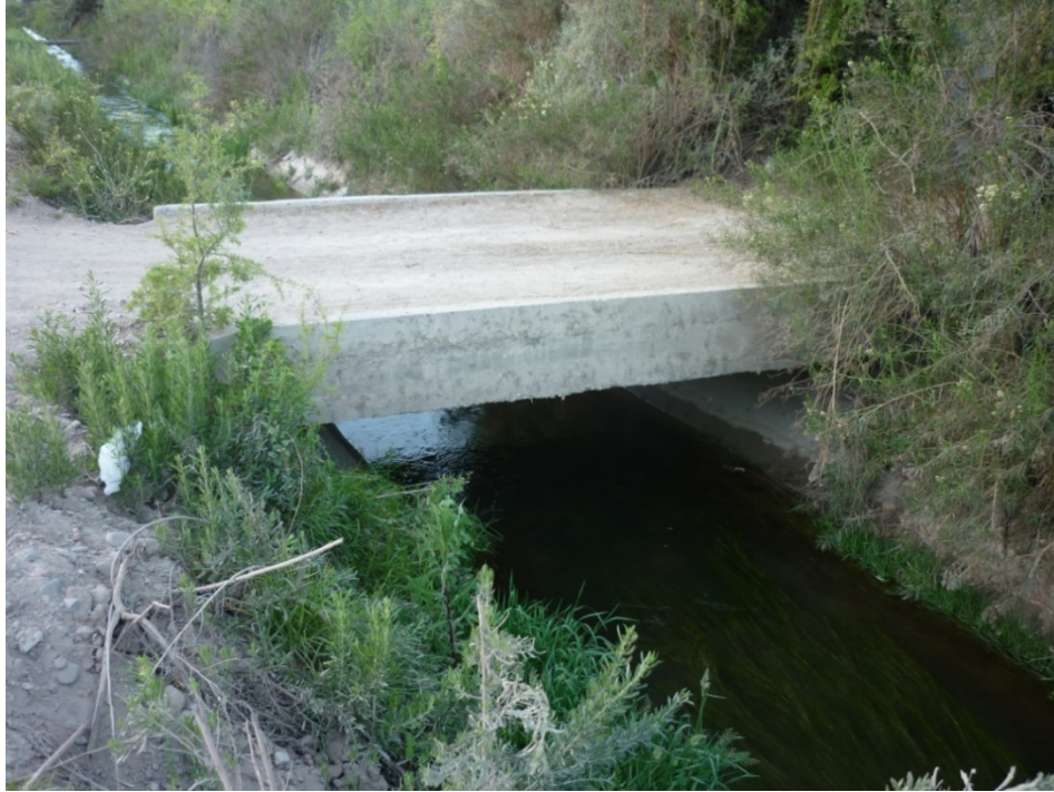
Figura 3.5: Puente losa típico sobre el canal – Km 1+585
