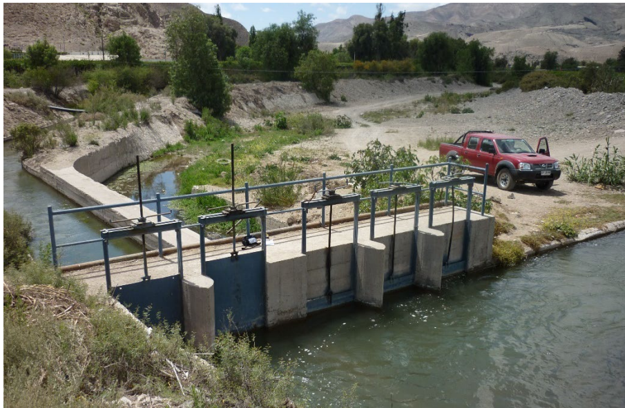
Figura 3.1: Bocatoma 7 compuertas, inicio del Canal Mal Paso
