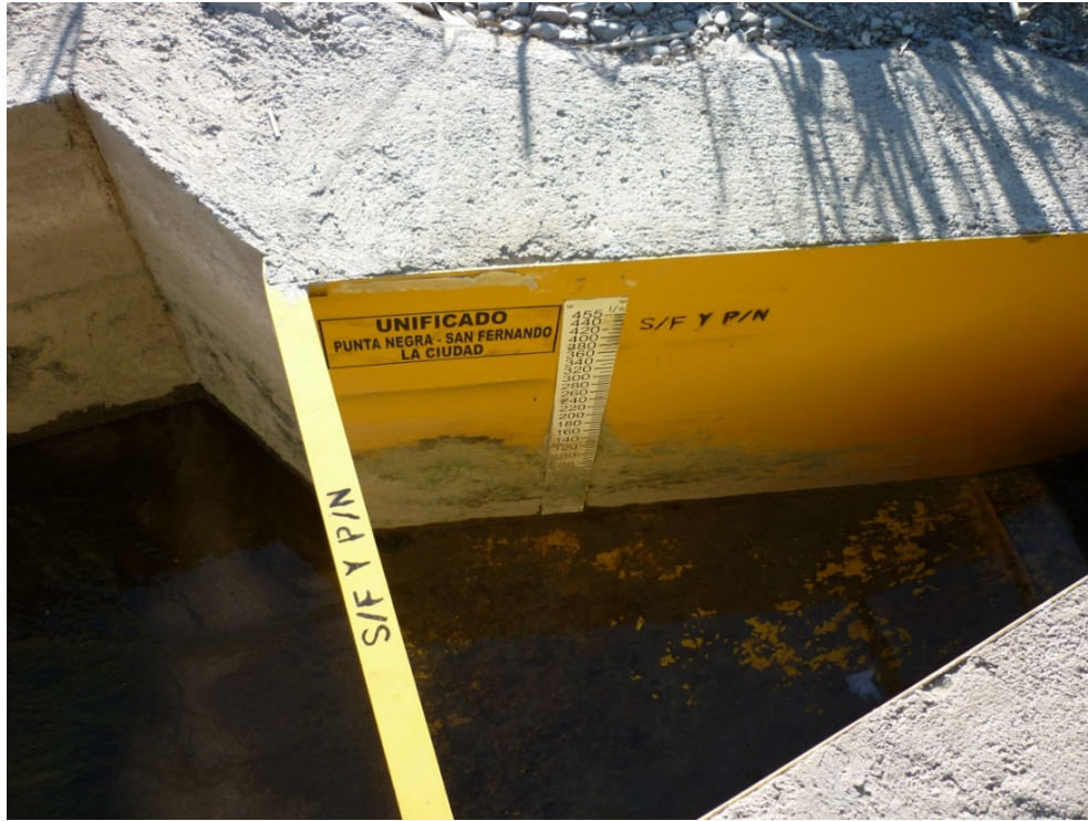
Figura 3.7: Aforador Parshall típico – Km 10+612
