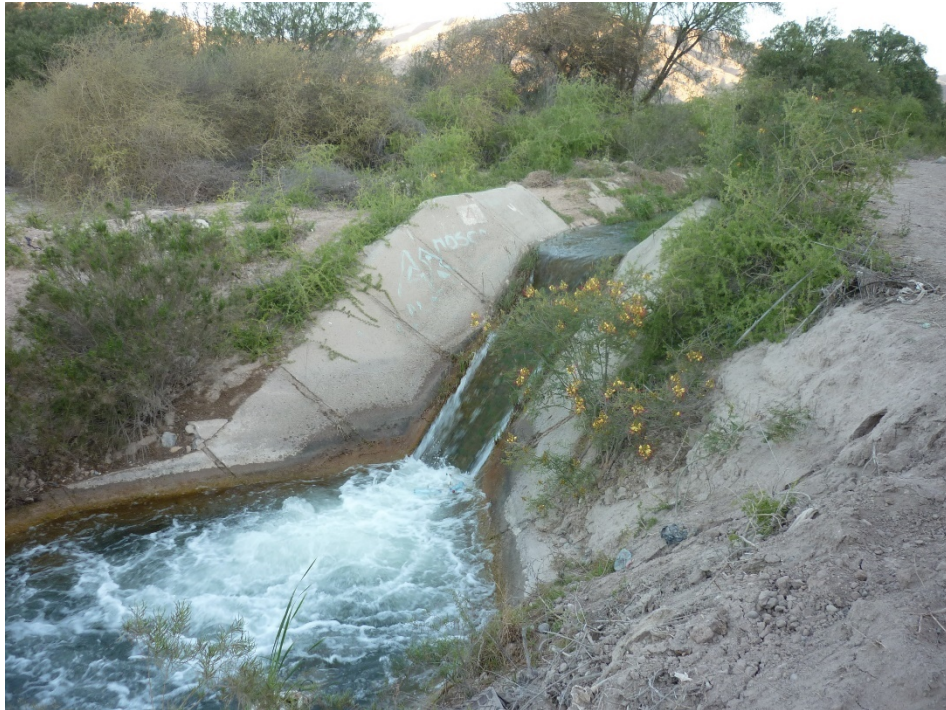
Figura 3.4: Caída N°4, Km 1+819 – Caída típica de 3 m de altura
