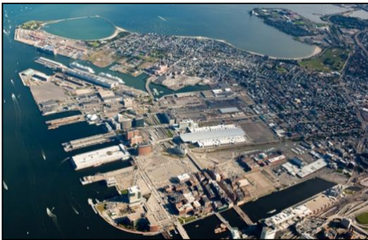
Ilustración 12 Vista área del South Boston/ Fuente Massport
