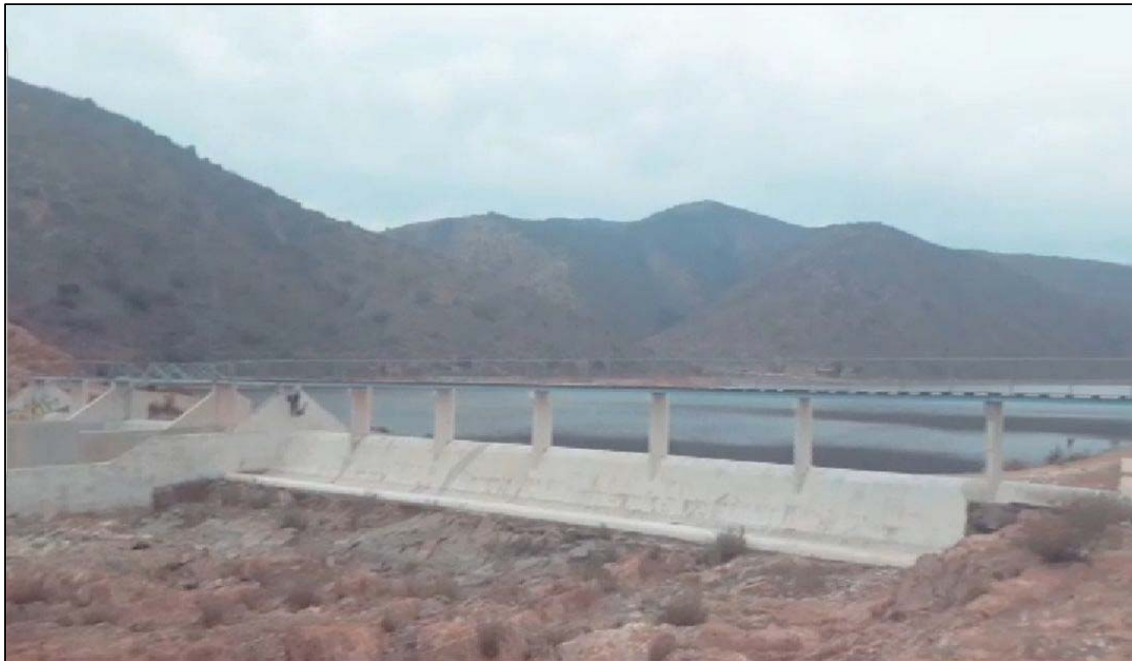
Figura 3.3: Muro y vertedero Embalse Culimo, Sept/2019.
