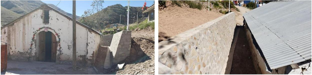
Figura 3.35: Muro de contención iglesia de Chusmiza, año 2019.
